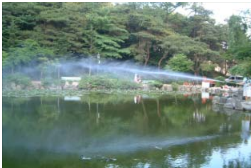
[그림 3.3.37] 연적지에서 고압 분무기를 이용하여 응집제를 투여하는 모습
