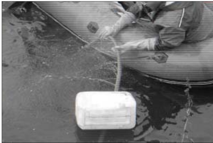
[그림 3.3.34] 흥부 저수지에서 호스의 구멍으로 황산알루미늄을 투여하는 모습
