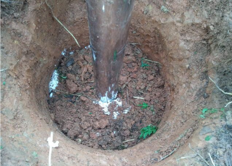
f. 고정을 위해 콘크리트 보형물을 끼워 넣는다.
