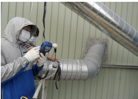
집진 덕트 풍속 측정
