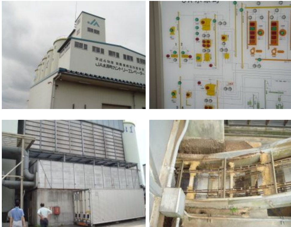
그림 3-2-5. 일본 니이카타현(新潟縣) 水原町の 농협CE에 설치된 세정식집진시스템
