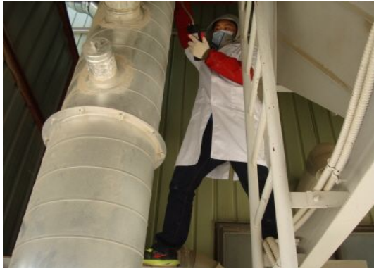
송풍 정압 측정
