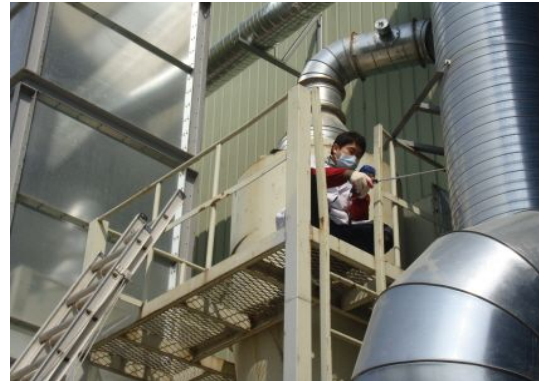
송풍 덕트 풍속 측정
