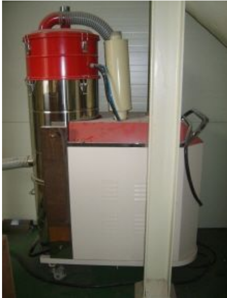
(I RPC에 설치된 12.6kW 청소시스템) (O RPC 현미부에 설치된 22.2kW 청소시스템) 그림 3-1-21. 2개소 제2세대 RPC에 설치된 흡인식 청소시스템
