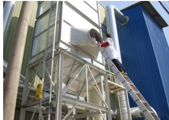
배출구 송풍량 측정
