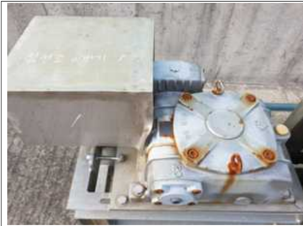
<그림 16> 기존 감속모터 및 스프라켓
