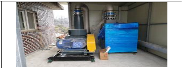
<그림 34> 터보브로워 및 루츠브로워 설치
