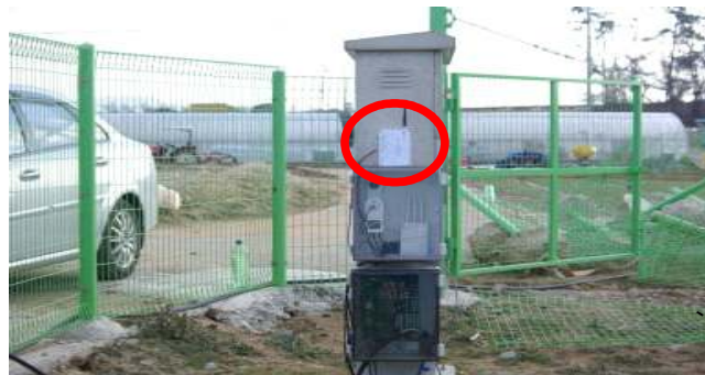
그림 8. 태양광 발전 보호를 위한 기상 관측 및 실시간 모니터링 기상 계측장치.
