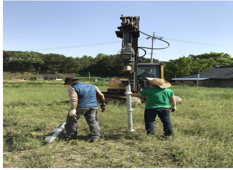
그림 39. 태양광 이모작용 부분나사 타입 나사말뚝 기초파일 설계도면 및 시공 모습.
