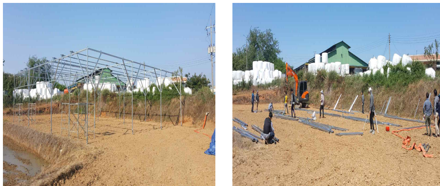
그림 45. 민원발생에 따른 벼 전용 태양광 이모작 구조물 구축 및 철거 사진.
