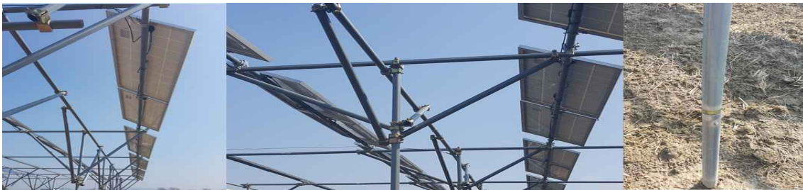
그림 36. 슬라팜(주)의 기 구축 태양광 이모작 구조물 시공 사례.
