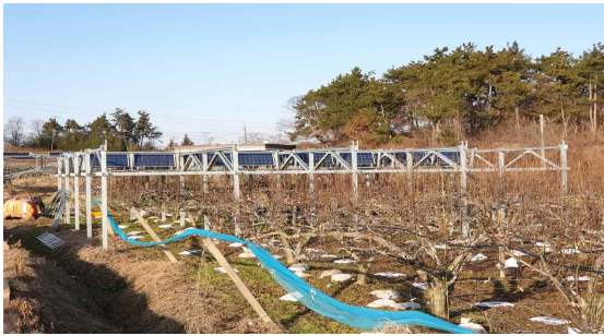
그림 65. 개선형 와이어텐션 장치 적용 후 접이식 모듈 구동 모습; (a) 모듈 접힘 상태 및 (b) 모듈 펼침 상태.
