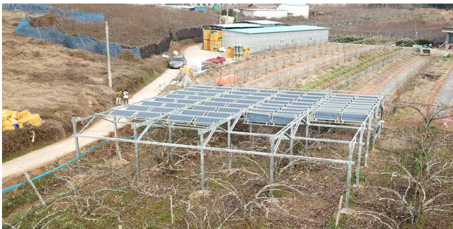
그림 59. 10kW급 배전용 접이식 구조물 구축 완료 모습.
