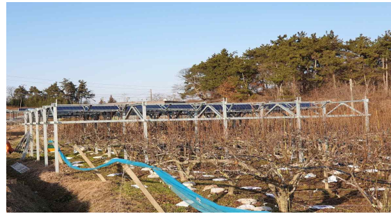
그림 65. 개선형 와이어텐션 장치 적용 후 접이식 모듈 구동 모습; (a) 모듈 접힘 상태 및 (b) 모듈 펼침 상태.
