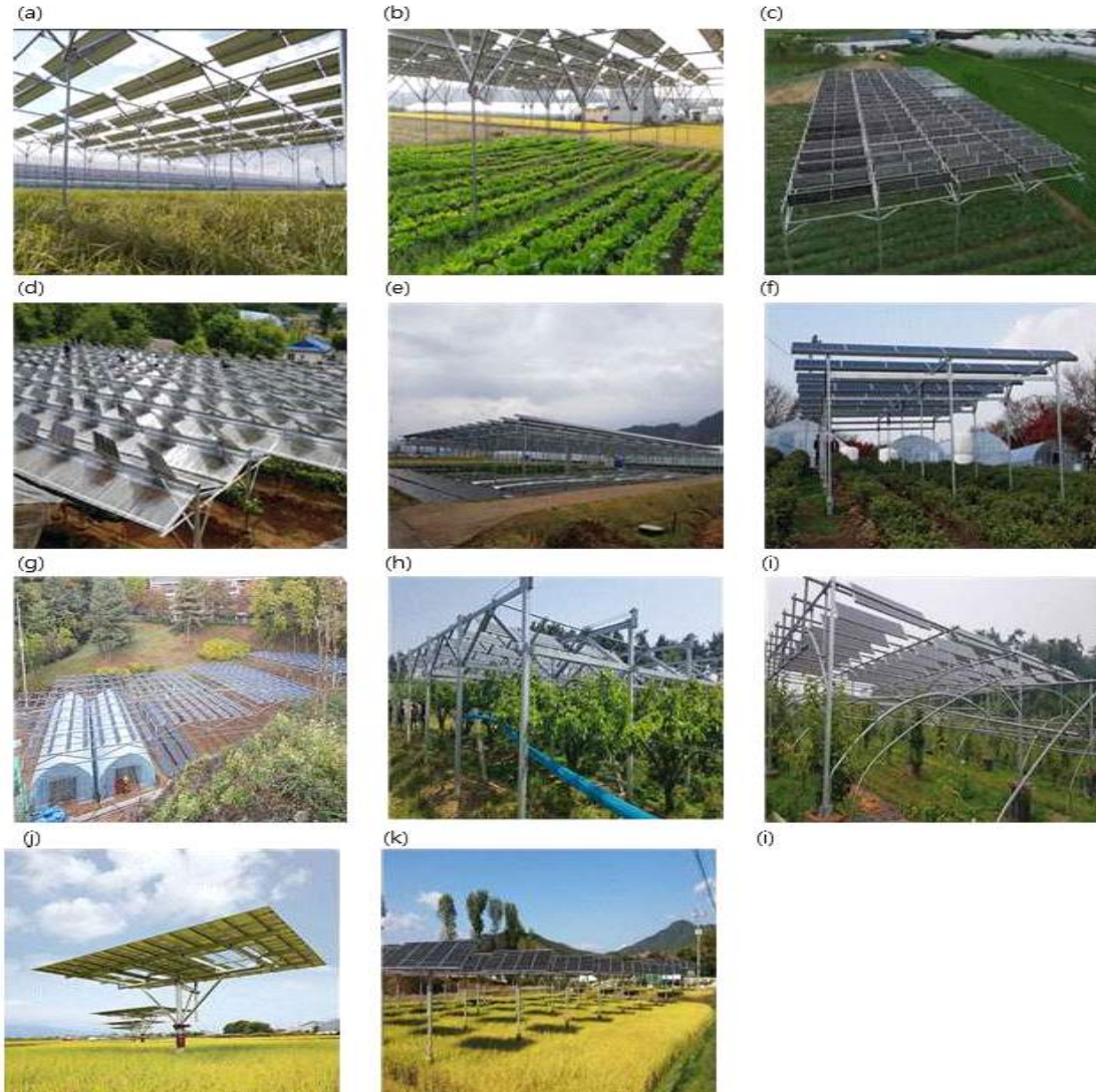
그림 24. 국내 농업 & 태양광 발전 병행 시스템 개발 및 실증 개표 사례; (a) 15kW급 벼 실증단지/충북 오창 (솔라팜), (b) 15kW급 밭 실증단지/충북오창 (솔라팜), (c) 100kW급 밭 실증단지/충북 오창 (솔라팜), (d) 100kW급 포도 실증단지/인천 영흥 (남동발전), (e) 100kW급 밭 실증단지/전남 나주 (전남농업기술원), (f) 10kW급 녹차 실증단지/전남 보성 (전남농업기술원), (g) 70kW급 밭 실증단지/경기 성남 (해여름), (h) 10kW급 배 실증단지/전남 나주 (녹색에너지연구원) (i) 10kW급 배 실증단지/전남 나주 (녹색에너지연구원) (j) 100kW급 벼 실증단지/전남 순천 (과루), (k) 73kW급 벼 실증단지/경기 가평 (한국수력원자력).
