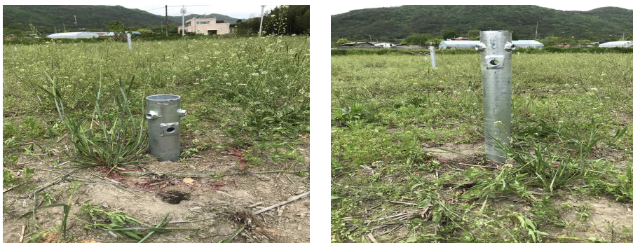
그림 38. 지반 특성에 따른 전나사 타입 나사말뚝 불규칙적 시공 모습.
