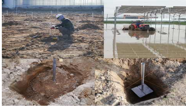
그림 35. 기 구축 중복 오창 논 실증단지 내 기초시공에 따른 문제점 도출.
