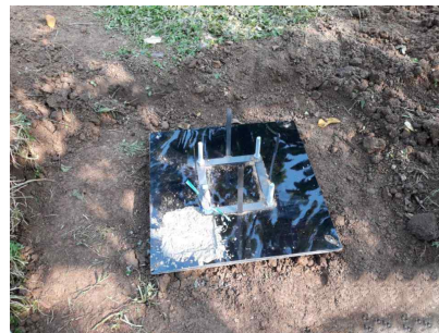
그림 41. 한국형 태양광 이모작 구조물용 FRP-독립기초시공 모습.
