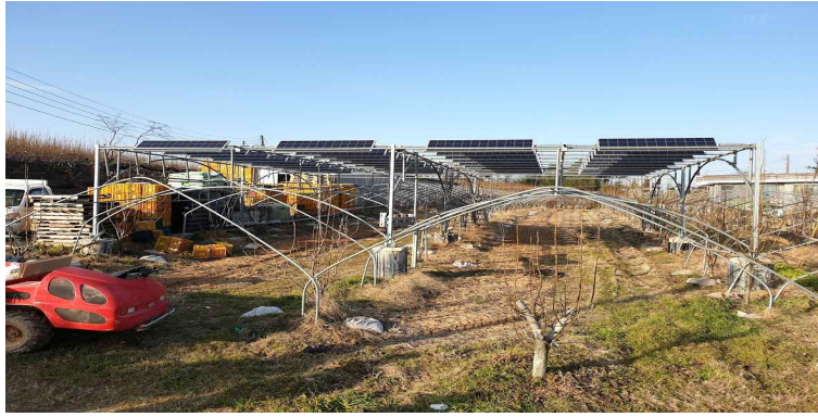
그림 70. Y 지주형 배 전용 태양광 이모작 구조물 구축 완료 모습.
