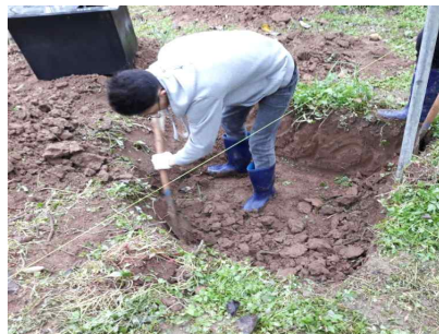
그림 41. 한국형 태양광 이모작 구조물용 FRP-독립기초시공 모습.
