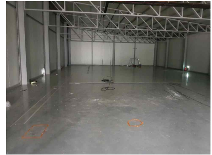
[바닥 에폭시 작업]
