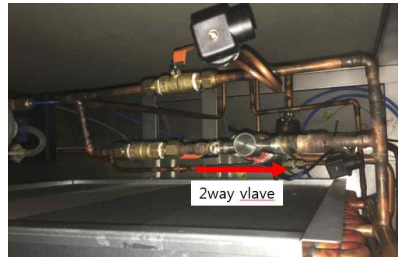
(b) 2way valve 설치 후
