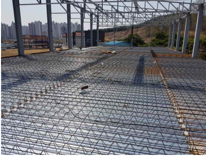
[바닥 기초 공사]
