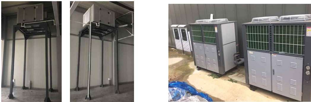
(a) 향온향습기 실내기 설치 (b)향온향습기 실외기 및 전장판넬 설치
