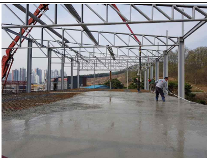
[재배 건축물 공사]
