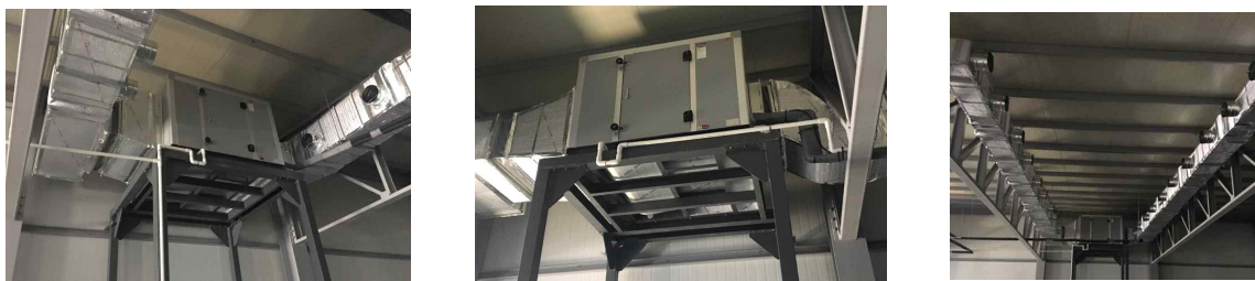
<그림 12> 덕트 시공 사진
