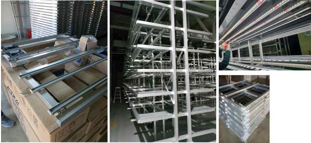
[모듈 제작과 현장 설치 사진]
