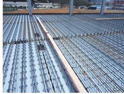
[배관 및 전기 위치 선정]
