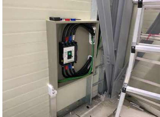
(d)내부 분전함 설치
