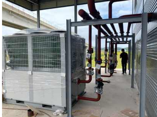
(f) 공기열 히트펌프 및 배관 설치(1)
