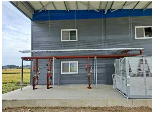
(h) 공기열 히트펌프 및 배관 설치(3)
