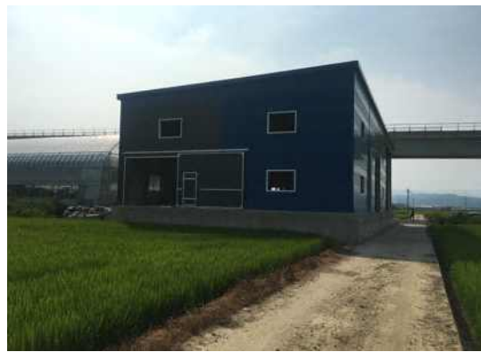
(k)기계실 설치 후 (동측)
