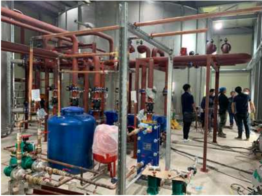
(e) 열공급배관 설치(4)
