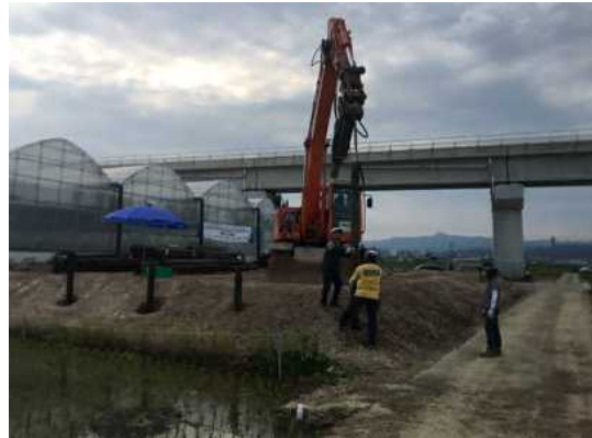
(b) 말뚝기초 시공
