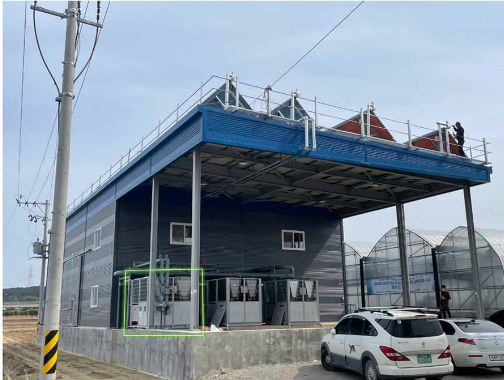
[그림 4-127] 실증시설원에 태양열 계간축열 기반 열공급 시스템내 복합열원 히트펌프 구축 전경
