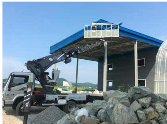
(i)지붕 패널 설치
