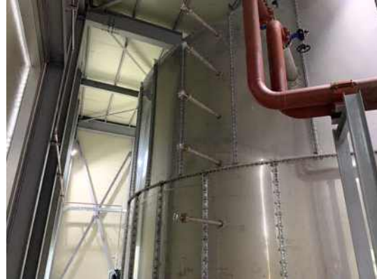
(d)축열조 온도센서 설치(1)
