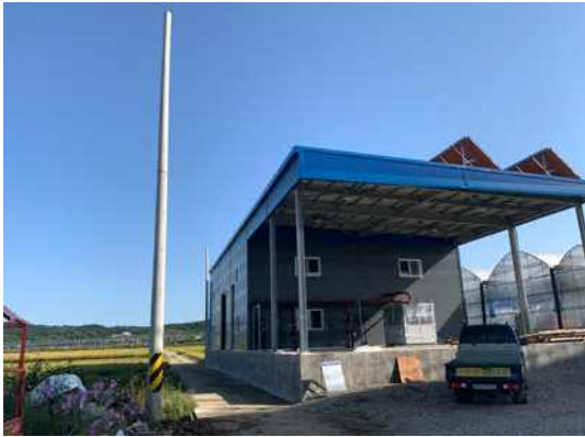
(a)전력증설용 전신주 설치
