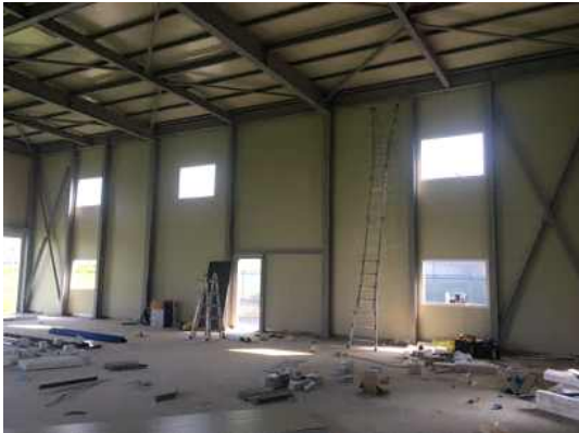
(h)벽체 패널 설치
