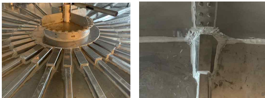
(b) 중앙부위 접합부 보강 후 (b) 모서리부위 접합부 보강 후
