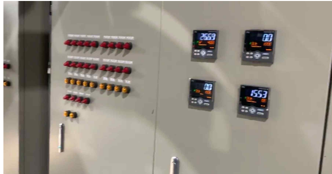
<운영관리시스템을 위한 PLC 판넬 모습>
