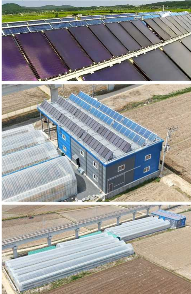
[그림 4-117] 실증 시설원에 적용 태양열 집열기 설치 모습
