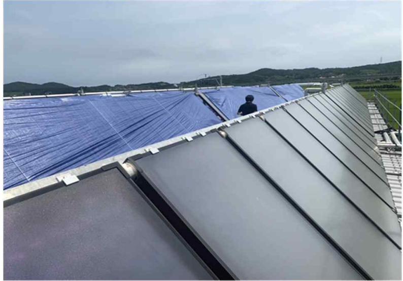
[그림 4-142] 평판형 집열기 집열능력 저하 모사: 집열면적의 50% 가림막 설치
