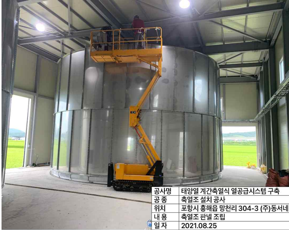
[그림 4-120] 계간조 단열 시공 전 사진
