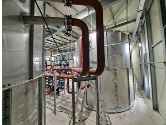
(d) 열공급배관 설치(3)
