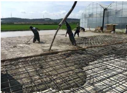
(g) 콘크리트 타설
