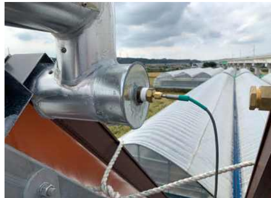
(h)집열기 출수 온도센서 설치 후
