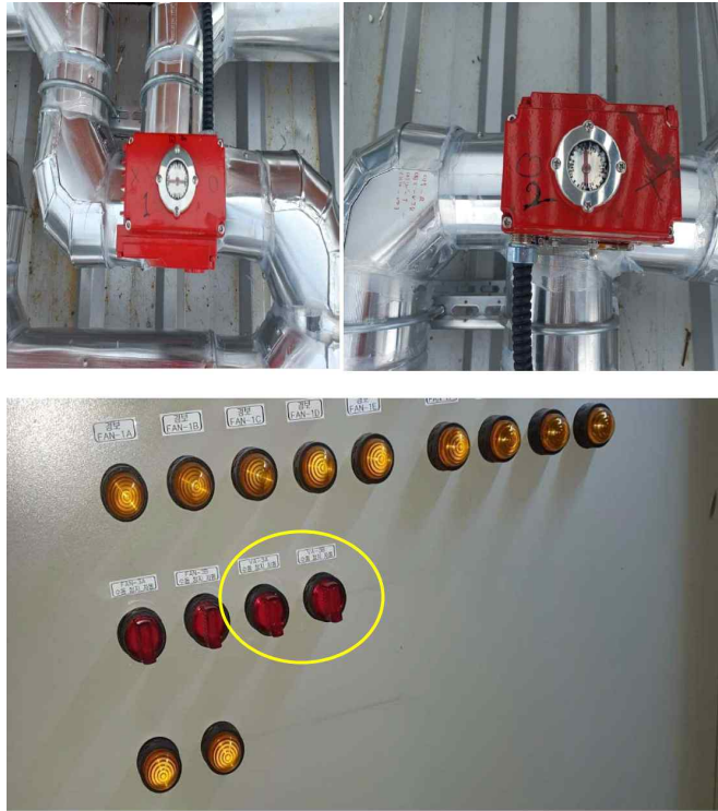
[그림 4-103] 태양열 과열방지 시스템 제어 시운전
