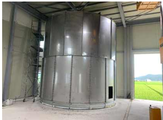
(d)버퍼조 100ton 설치(외부)-1
