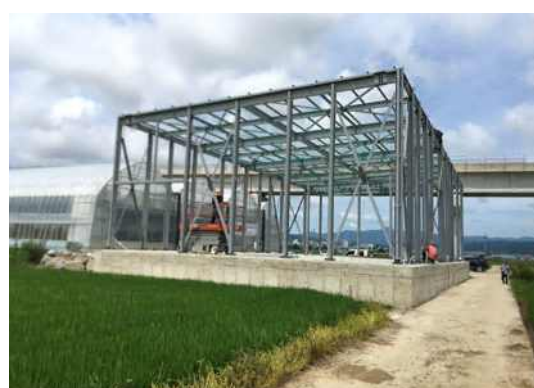
(g)보 철골구조물 설치
