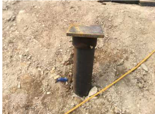
(d) 말뚝기초 시공 후
