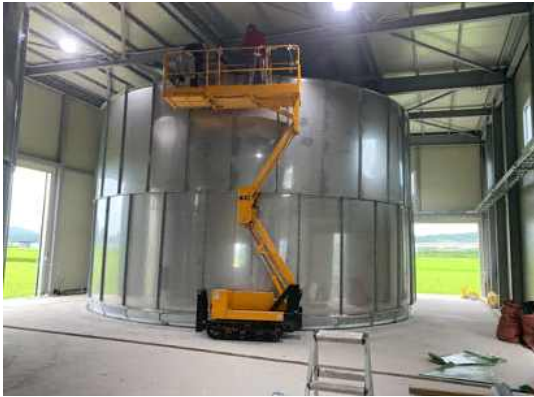
(a)계간조 350ton 설치(외부)-2
