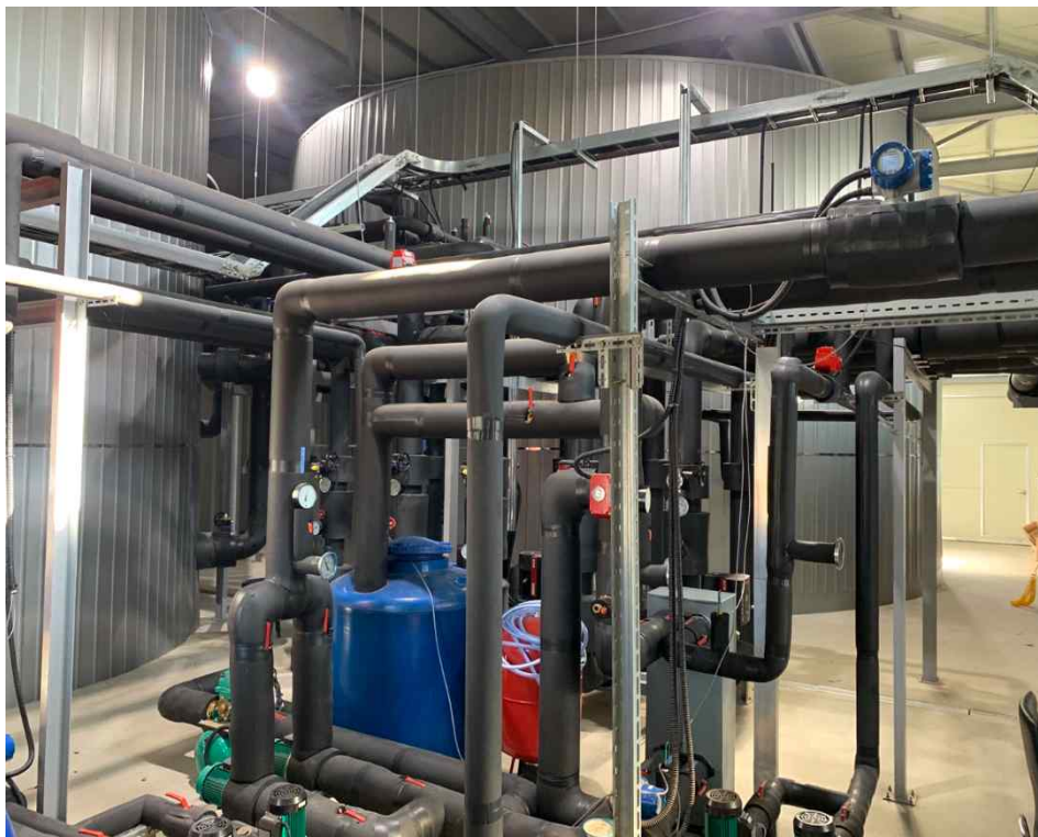
[그림 4-121] 계간조 단열 시공 후 사진
