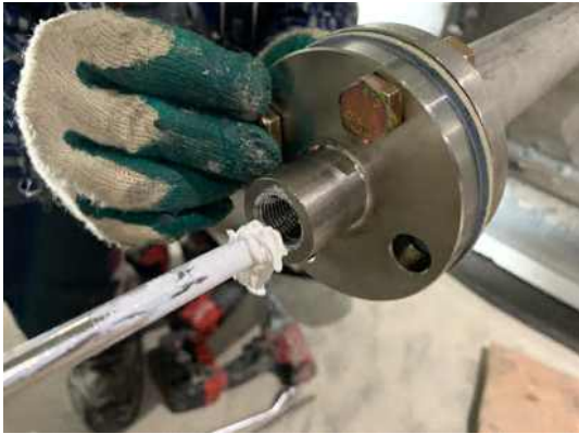
(c)축열조 온도센서 설치(1)
