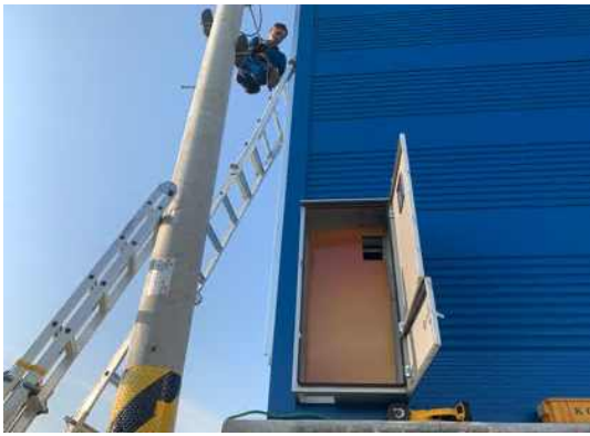
(c)외부 분전함 설치
