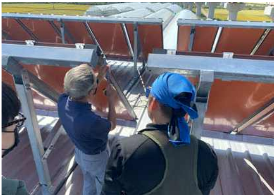
(e)집열기 온도센서 케이블 설치(1)
