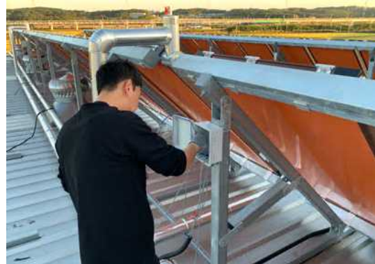
(f)집열기 온도센서 케이블 설치(2)
