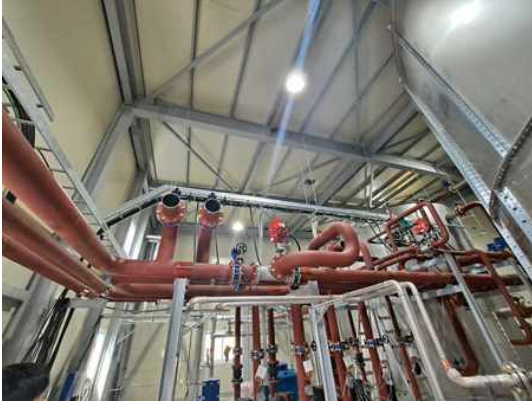
(c) 열공급배관 설치(2)
