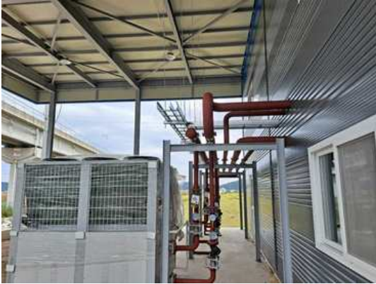
(g) 공기열 히트펌프 및 배관 설치(2)
