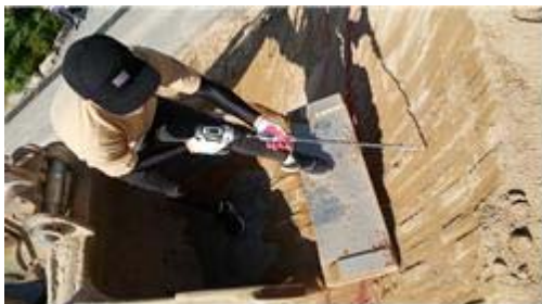
(a) 센서 설치
