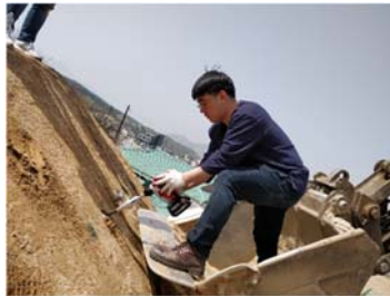
그림 61. 지중변위센서 설치(출처: 참고문헌 [3])
