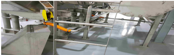
※ 변경 후 건조기 전경 ↑ (하단 배수로 설치)
