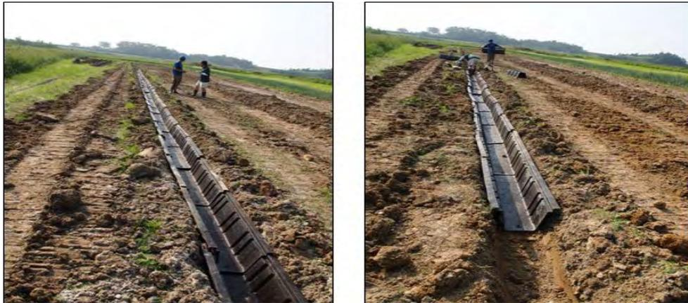
그림 67. 이랑과 이랑 사이 천공 배수로 천공배수 설치 현장 사진
