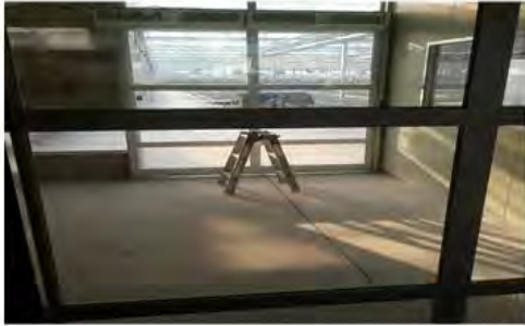
<그림1-2> 두 개의 문이 동시에 열리지 않도록 온실 내 이중 문 설치
