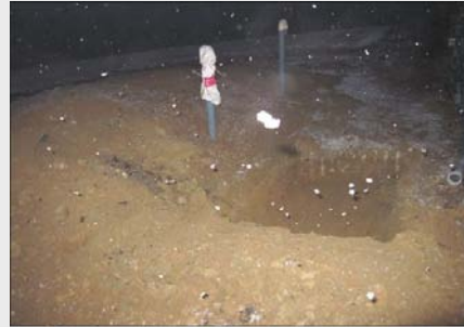
⑫ 응급저류조 설치
