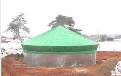
⑤ 저장조를 지붕 밀봉 후 가스배출관 설치
