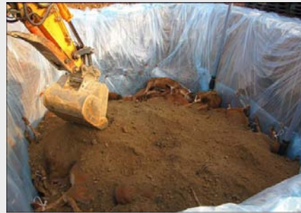
⑥가축사체위 가스관 설치 후 흙 덮기
