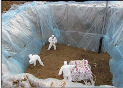
③침출수 유공관 설치
