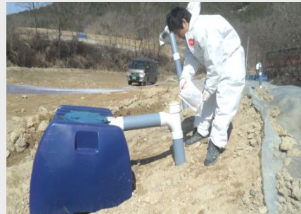
YT관 설치 및 친환경미생물제 투입
