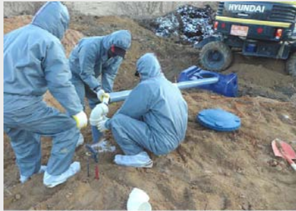
FRP 저류조 연결작업
