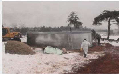
② 저장조 설치 (외부 강판, 내부 방수 처리된 특수 천막)
