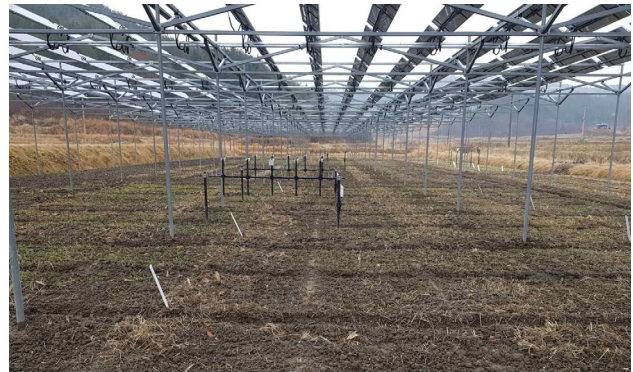
100kwh 영농형태양광 모듈설치 위치도(보성) 영농형태양광 모듈하부 센서설치 및 자료수집
