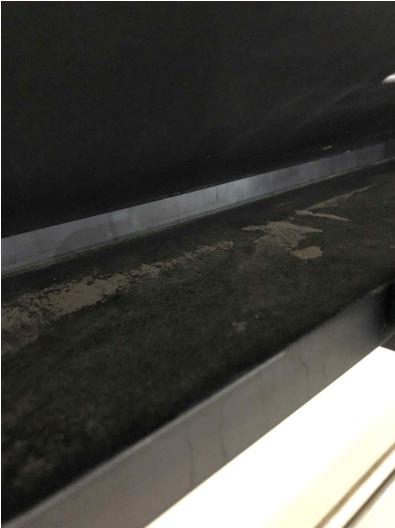
입기구 하단 세척 미흡 그림 D농장 세척 육안검사 시 미흡사항
