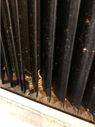
환기팬 라이트트랩 세척 미흡 그림 A농장 세척 육안검사 시 미흡사항
