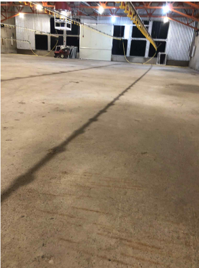
세척제 세척 후 바닥 터널
