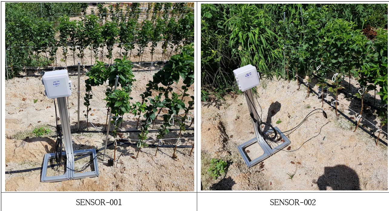
그림 4-3-12 북경화풍원예장 온습도 센서 설치
