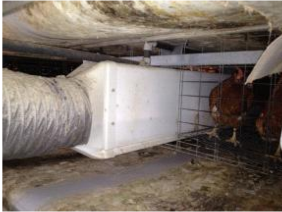
그림 3-28 계사내부의 계분건조용 덕트 ( 닭진드기의 주요 은신처)
