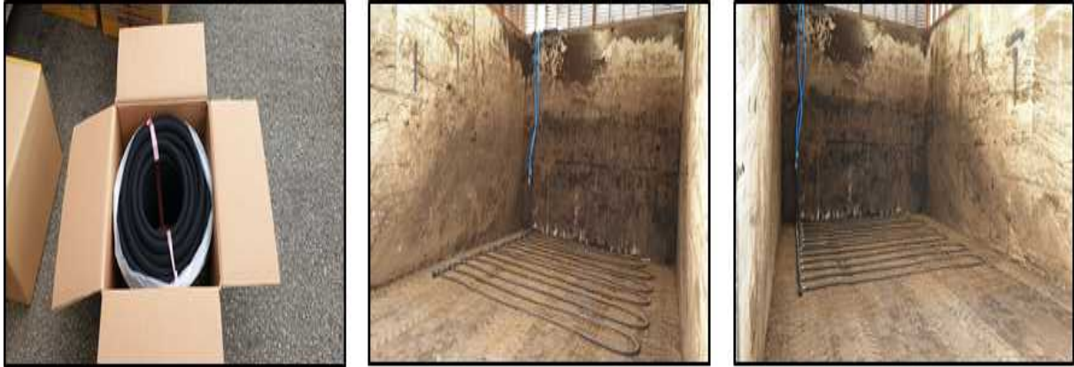
그림 100. 저압 분산 고무 질호스(유니바이오희스) 설치 모식도 및 설치방법
