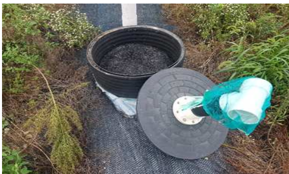
<그림 9> FRP 저장조의 탈취조 및 가스 배출구 현황 (D시)
