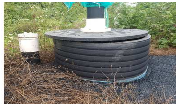
<그림 9> FRP 저장조의 탈취조 및 가스 배출구 현황 (D시)
