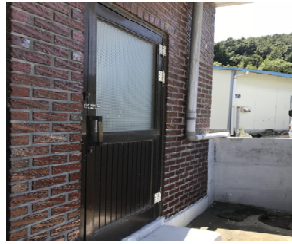
ii) 1층 화장실
