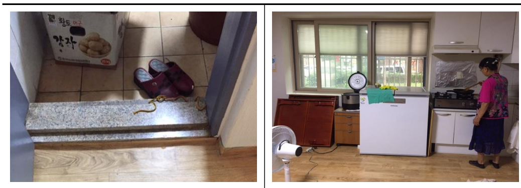
<그림 16> 고양 방기 경로당 부위별 리모델링 후 불편사항
