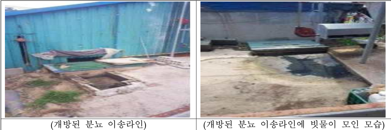
<그림 67> 돈사 슬러리피트 배출구 및 개방된 분뇨 이송 배관 사례
