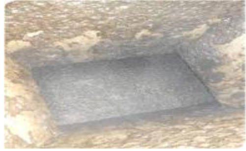
(액비저장조 내부(유지보수 개폐문))
