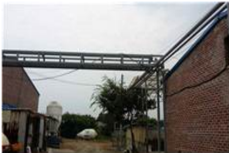
영천 S 농장 (액비순환시스템 배관연결 사진)
