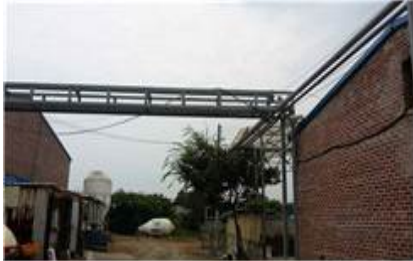
영천 S 농장 (액비순환시스템 배관연결 사진)
