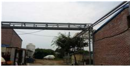
영천 S 농장 (액비순환시스템 배관연결 사진)
