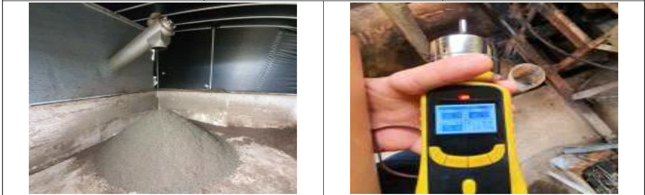
(밀폐된 고액분리시설 내부 및 악취측정)
