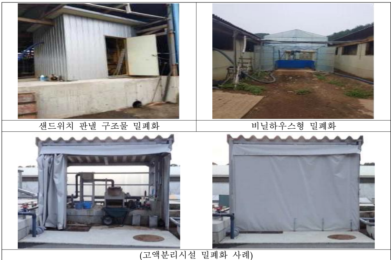
<그림 71> 고액분리기의 종류 및 구조 (밀폐 및 개방)
