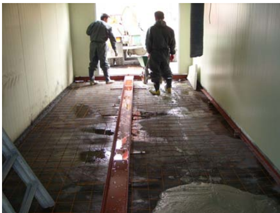
Fig. 5-13.바닥 콘크리트 작업
