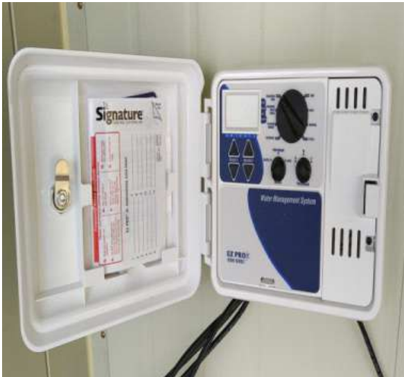
<관수 컨트롤러 및 펌프 패널 설치>
