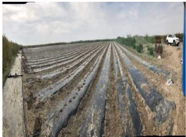
(화용 간척지 지하배수암거 설치완료)
