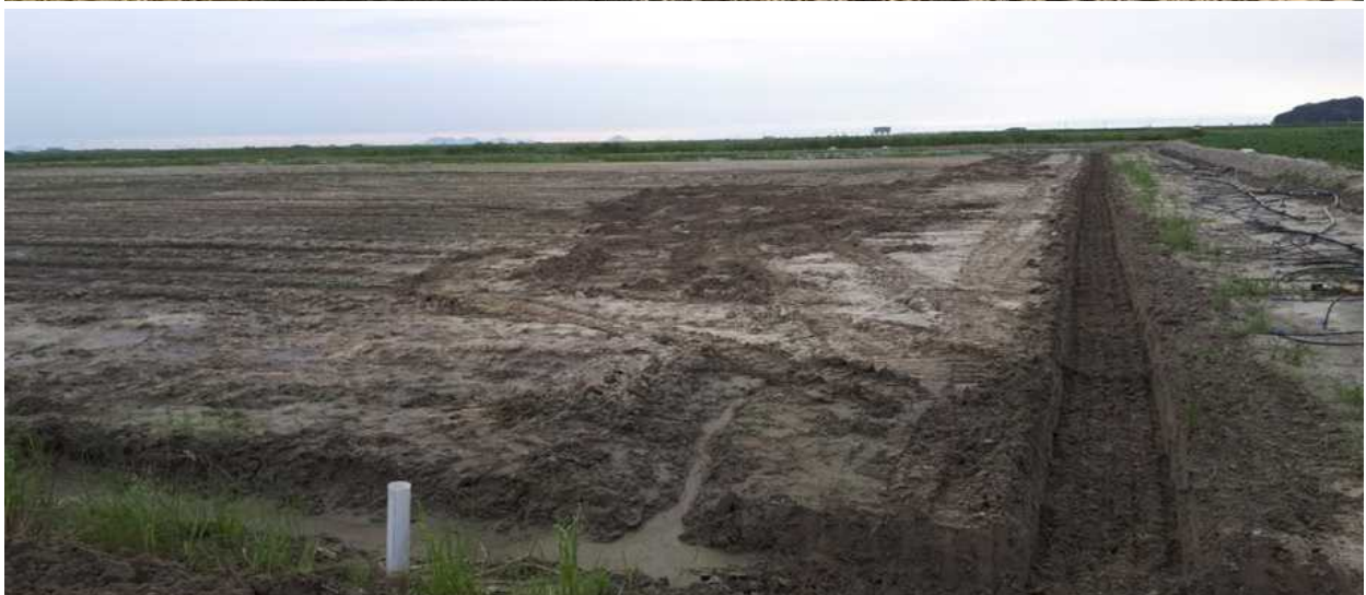
<그림 2-203> 경지 내 외곽배수로의 설치
