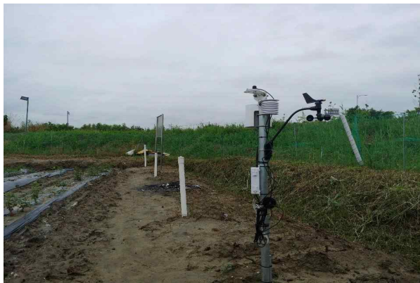
(설치 후 전경 (1))
