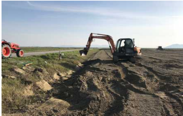
(시험포 외곽배수로 공사(1))
