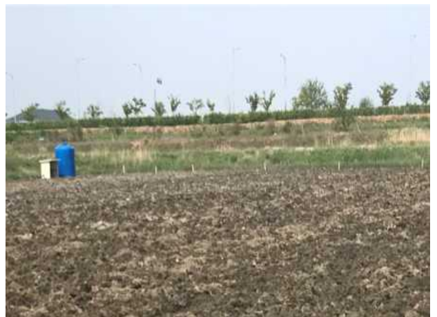
(석문 간척지 지하배수암거 설치완료)
