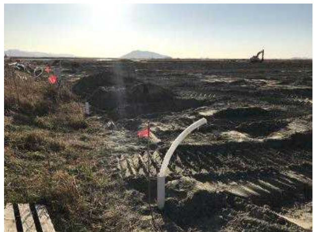
(새만금 간척지 지하배수암거 설치완료)
