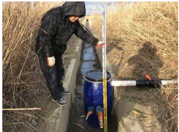
(배수로 침출수조 설치완료)
