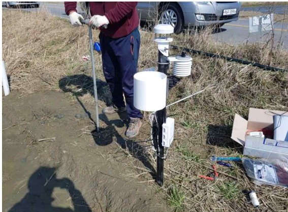
(기상장비 설치 및 지하수위측정 관정설치)
