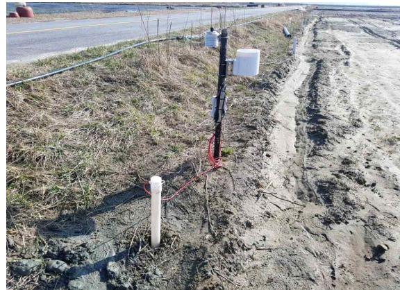
(설치 후 전경)
