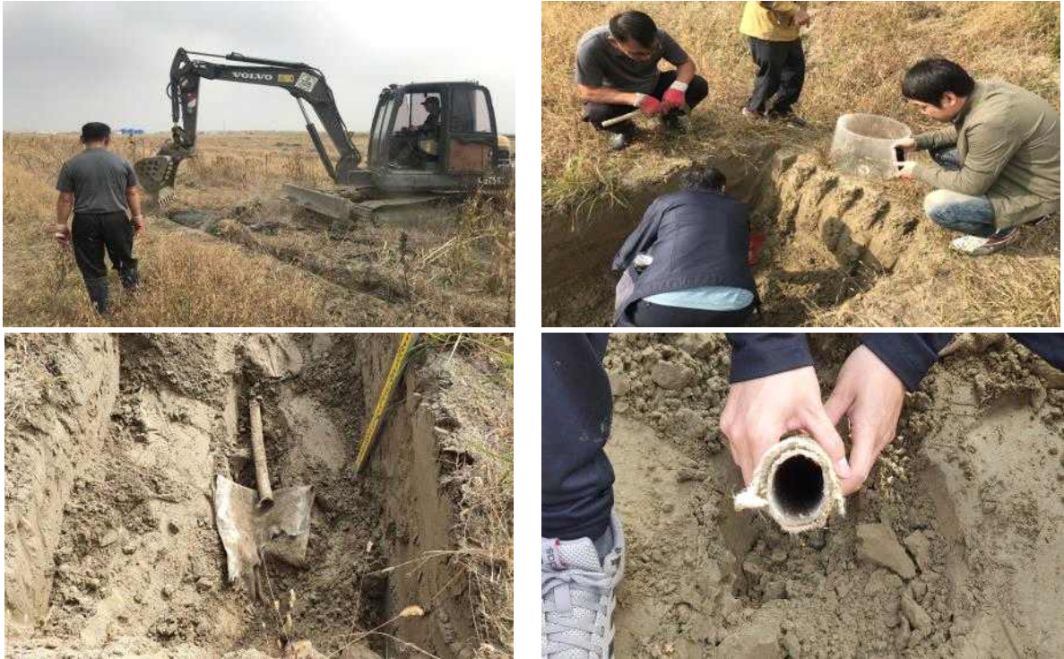
<그림 2-191> 간척지 시험포 무굴착 암거 내부 조사
