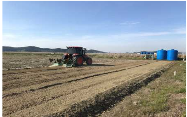
(시험포 외곽배수로 공사(2))
