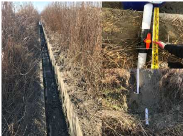
(배수로 침출수조 수압 설치)
