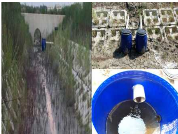
(배수로 침출수조 수갑 설치)
