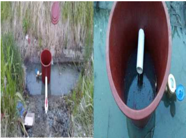
(배수로 침출수조 수갑 설치)
