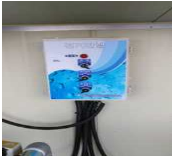
<관수 컨트롤러 및 펌프 패널 설치>
