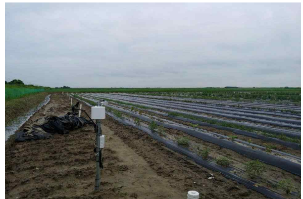
(설치 후 전경 (2))
