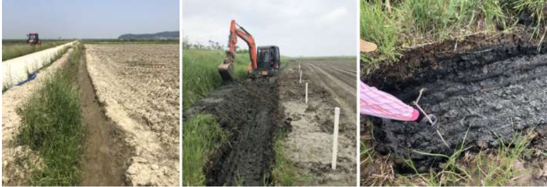
<그림 2-288> 석문 간척지 명거배수로 공사
