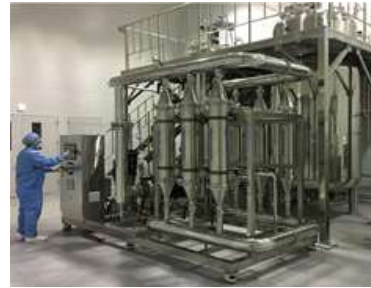
세라믹 필터 설치
