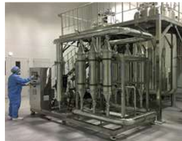
세라믹 필터 설치
