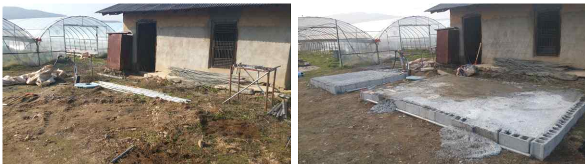
그림 57. 시스템 설치를 위한 기초 공사
