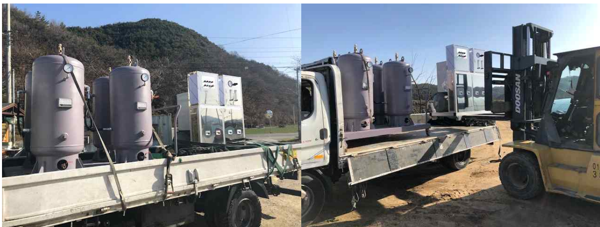
그림 81. 상용형 CO 2 포집 및 공급 시스템의 현장 설치
