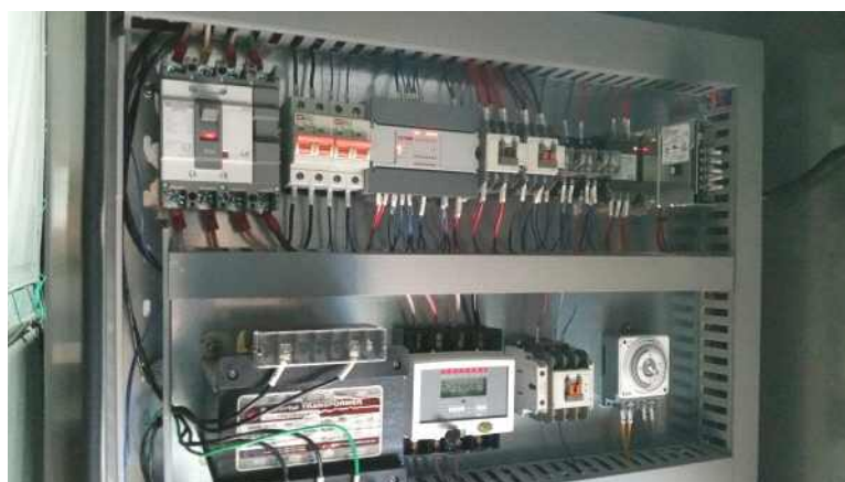
그림 59. 적산전력계와 타이머의 설치
