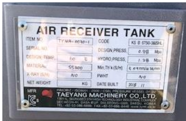
그림 79. 멤브레인 시스템 압축 탄산가스 탱크의 제원
