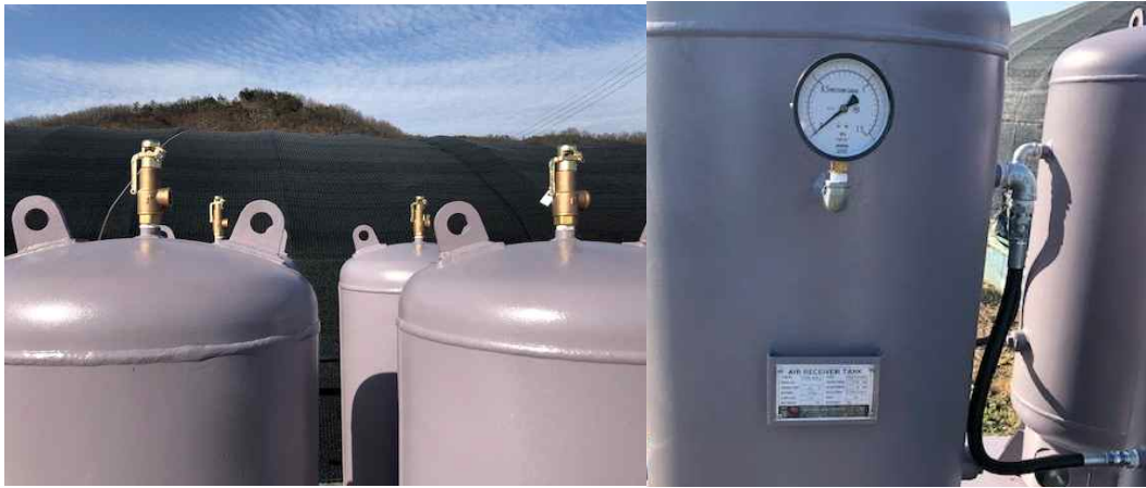
그림 80. 멤브레인 압축 탄산가스 탱크의 안전 밸브 및 압력계 부착
