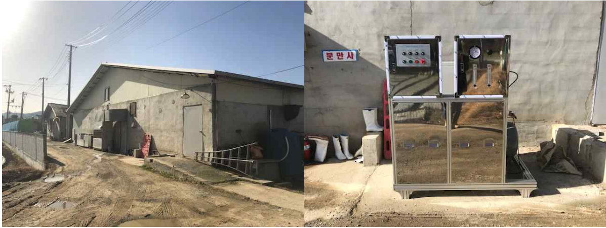
그림 82. 멤브레인 시스템의 축사 포집 시스템 설치
