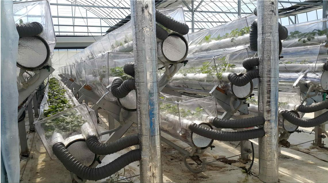
그림 4 딸기하우스 내부 스윙윈통베드 공조시스템(200mm)
