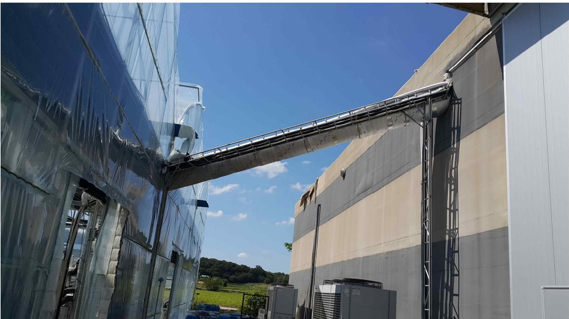
그림 3 버섯재배사(우측)에서 딸기하우스로 가는 배관(450mm) 모습
