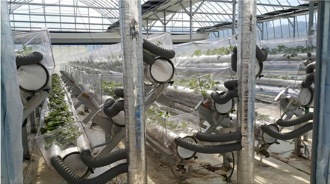
그림 7 스윙원통베드 국부냉방장치와 공조시스템(75mm)
