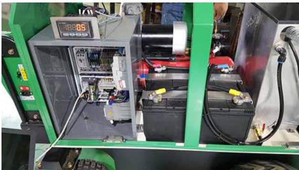
그림 36. PLC 자동제어장치 개발
