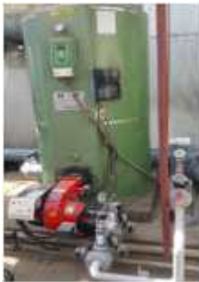
[광주육묘장 DME 버너 적용 온수 보일러, 온풍기 및 수관보일러 열교환기 및 배관 시설정비]
