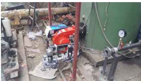
그림 2-2. 저NO x 버너 사용 보일러개조 및 DME 배관시설 설치작업
