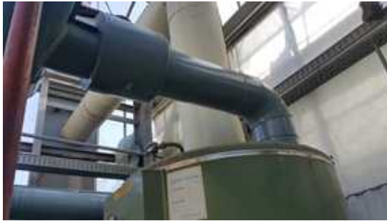
육묘장내 보일러의 수관열교환기 상층부(a) 수관보일러 열교환기 및 배관 시설정비(b)
