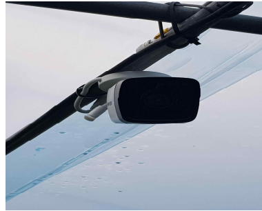
그림 2-32. 온도, 습도, CO2 센서 및 CCTV 설치
