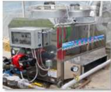
[광주육묘장 DME 버너 적용 온수 보일러, 온풍기 및 수관보일러 열교환기 및 배관 시설정비]
