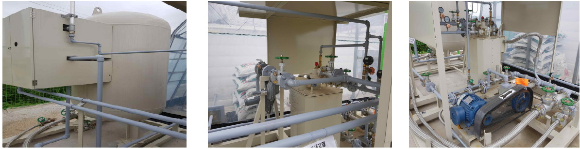
그림 2-27. DME 연료공급설비 설치
