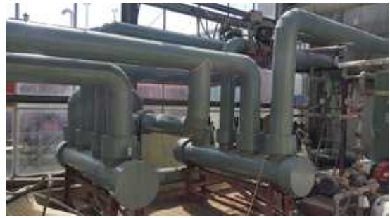
육묘장내 보일러의 수관열교환기 상층부(a) 수관보일러 열교환기 및 배관 시설정비(b)
