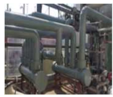
[광주육묘장 DME 버너 적용 온수 보일러, 온풍기 및 수관보일러 열교환기 및 배관 시설정비]
