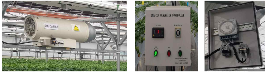
온풍 및 CO 2 발생기 CO 2 컨트롤러 그림 2-43. DME 가스연소식 온풍 및 CO 2 발생기와 컨트롤러
