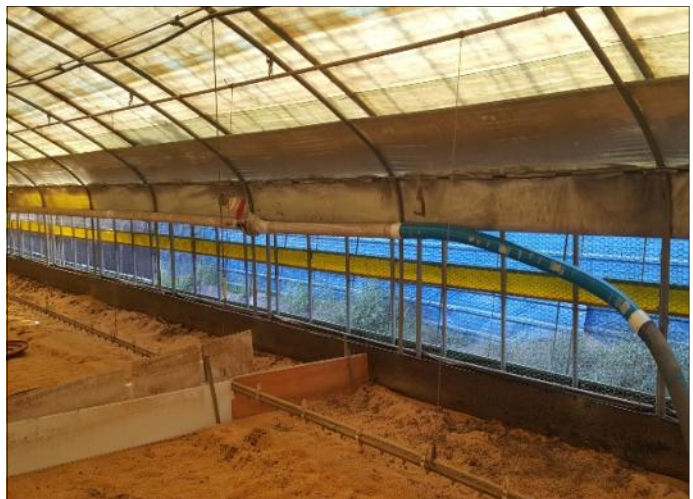
【 변경 후 내부 이송배관 사진】
