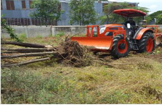
그림 4-6. 블레이드를 이용한 수목제거작업. 그림 4-7. 디스크헤로를 이용한 평탄작업.
