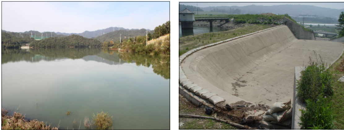
(그림 2-16) 무수저수지(전경 및 물넘이)
