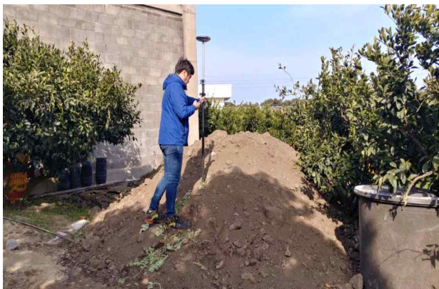
[그림 37] 지열공 착공전 전경 및 위치확인
