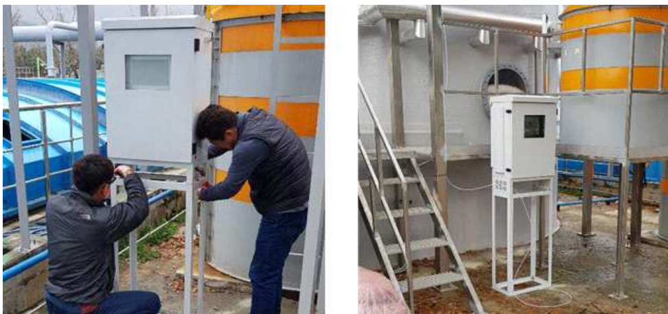
<그림 104> 축산악취 측정기 설치 사진
