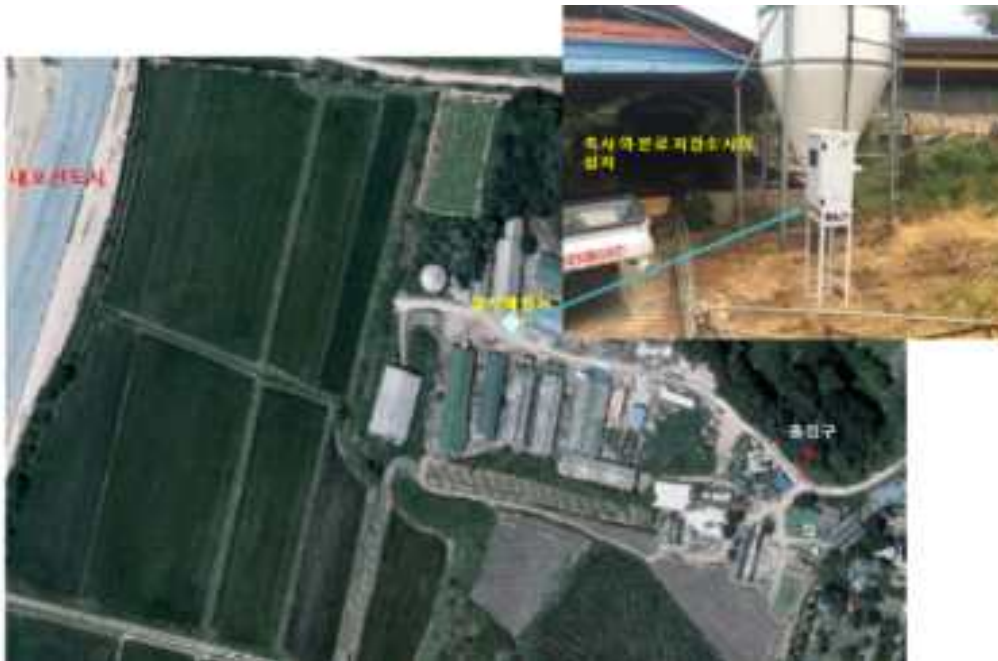
<그림 100> 대동농장 고정식 악취 측정기 설치 위치
