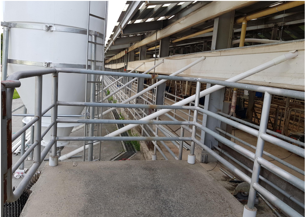
그림 218 사료빈 및 이송파이프 설치
