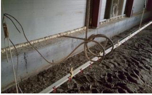
(a) 육계사의 환기 제어시스템 운영을 위해 설치된 내부온도 센서
