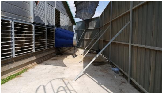
(c) 육계사 외부 설치된 방풍벽
