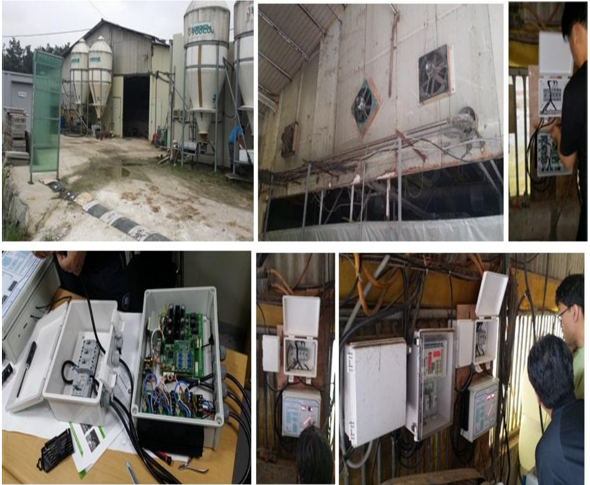
<설치 작업 사진>
