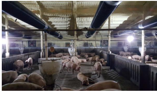
(c) 비육돈사 내 배기팬의 설치현황 (직경 0.5m, 1.0m 배기팬)
