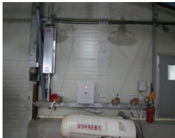
측면 벽체온도측정을 위한 열전대 설치
