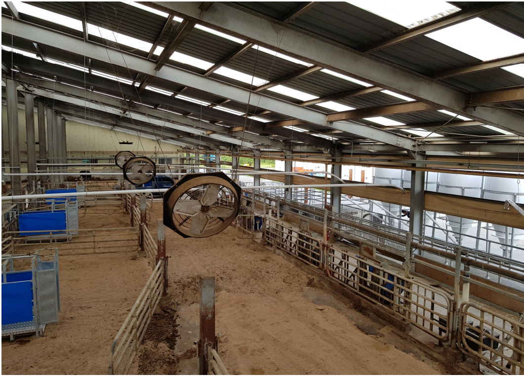
그림 219 축사용 환기팬 설치
