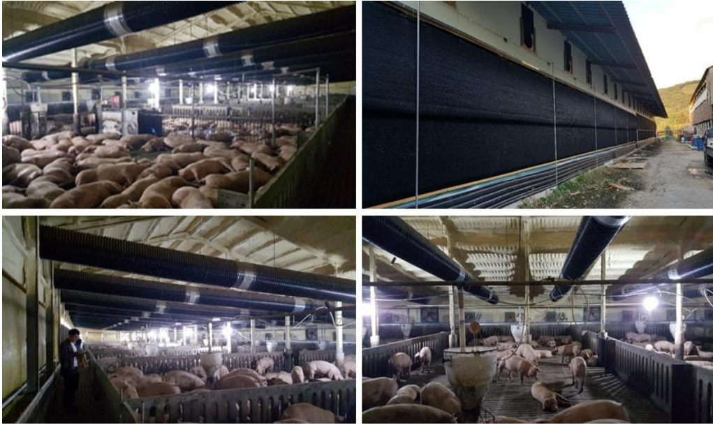
그림 3-5-15 실험 돈사의 내·외부 측사 현황 및 입·배기 구조
