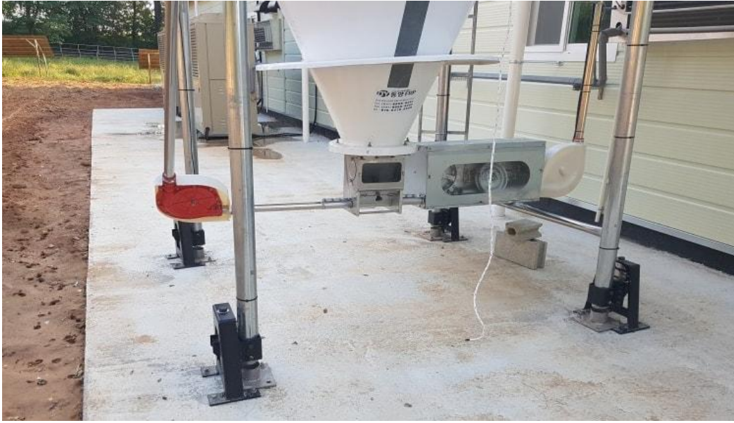
그림 179 사료탱크 다리에 로드셀을 설치
