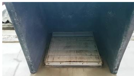
가변식 풍량 20% 동작 시 서터의 개방 정도 (거의 열리지 않는 상태)
