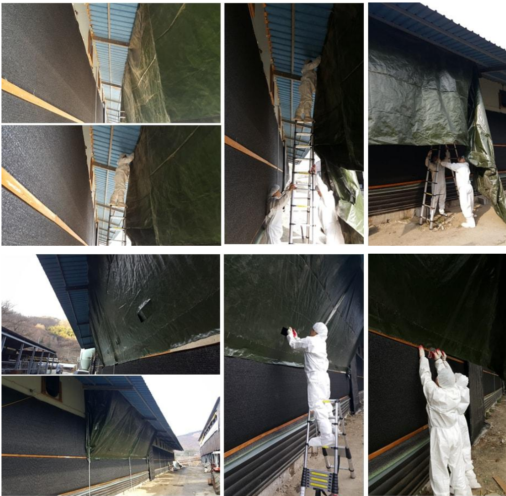
그림 3-5-16 실험 비육돈사 외부에 전실 설치
