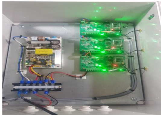
그림 181 내부 인디케이터 및 LORA모듈 설치
