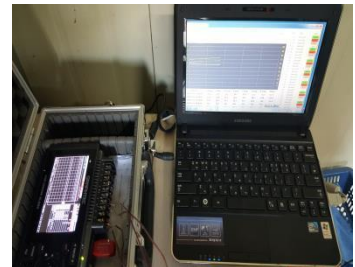
노트북 및 데이터로거 설치
