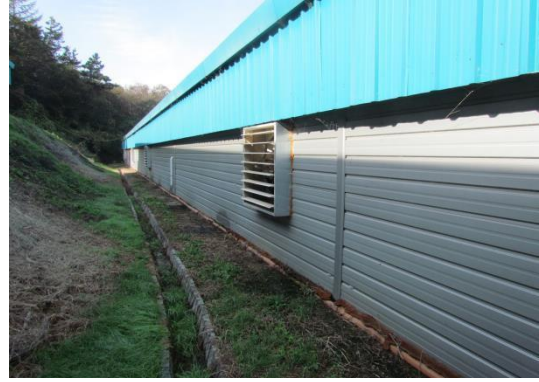
측벽 크로스배기팬 설치현황
