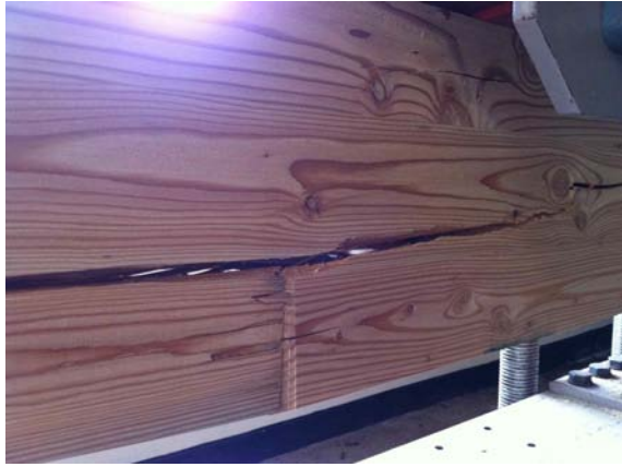
그림 B1-66 핑거 탈락 후 수평전단 파괴
