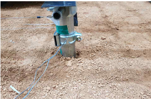
(a) 측면기둥 주각부 상태
