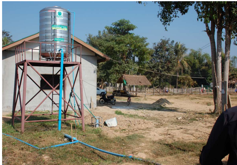
그림 81. 중력에 의한 관수 시스템 (밸브 Open-Close 방식)
