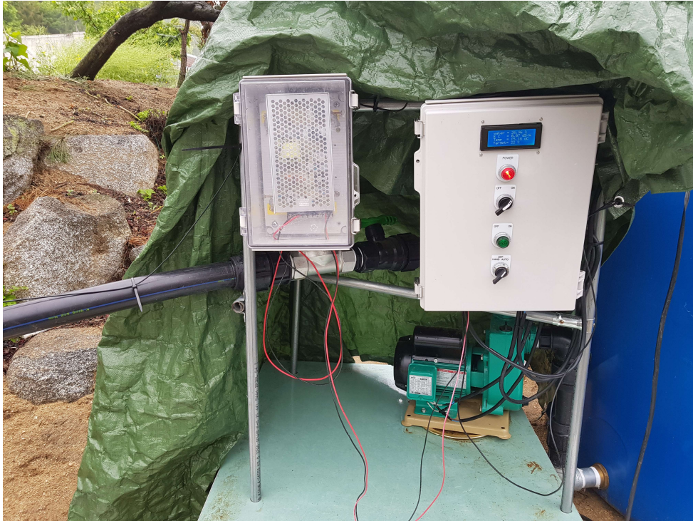
그림 136. 농가 보급형 관수 제어 시스템 모습
