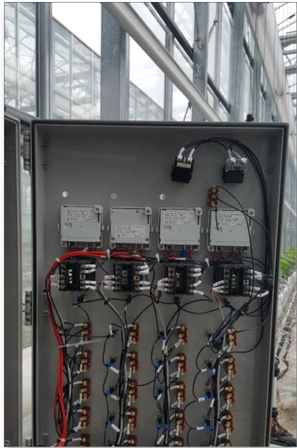
○ 기존 상용제어기 신호선의 Bypass 처리(붉은선) 및 원격서버와 연결
