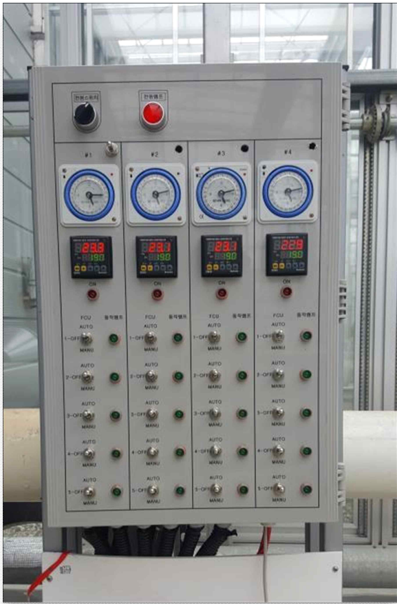
○ 기존 상용제어기 신호선의 Bypass 처리(붉은선) 및 원격서버와 연결
