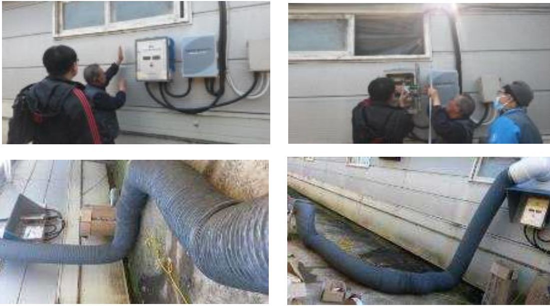
[그림 3-139] 돈사외부 배기라인 설치 및 악취저감시스템 연결사진도
