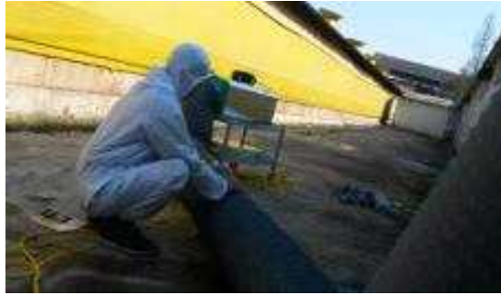
[그림 3-140] 돈사의외부 악취저감시스템 설치 및 시험
