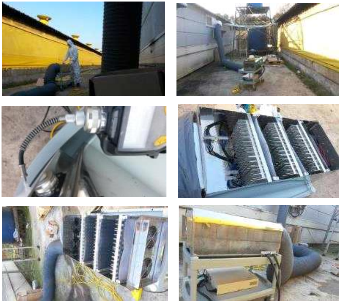
[그림 3-139] 돈사외부 배기라인 설치 및 악취저감시스템 연결사진도
