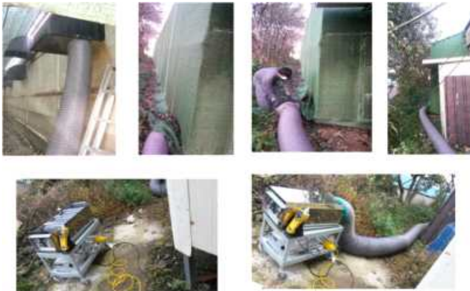
[그림 3-118] 악취저감장치내 돈사 배기가스 인입라인설치
