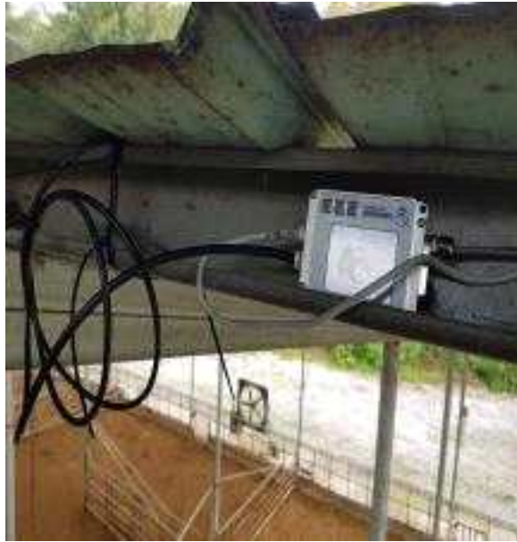
천장에 설치된 FIRA 4800-C 열화상 카메라
