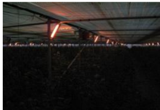
<그림 13> 김해시 진례면 시온장미원의 적외선램프 설치 비닐하우스난방
