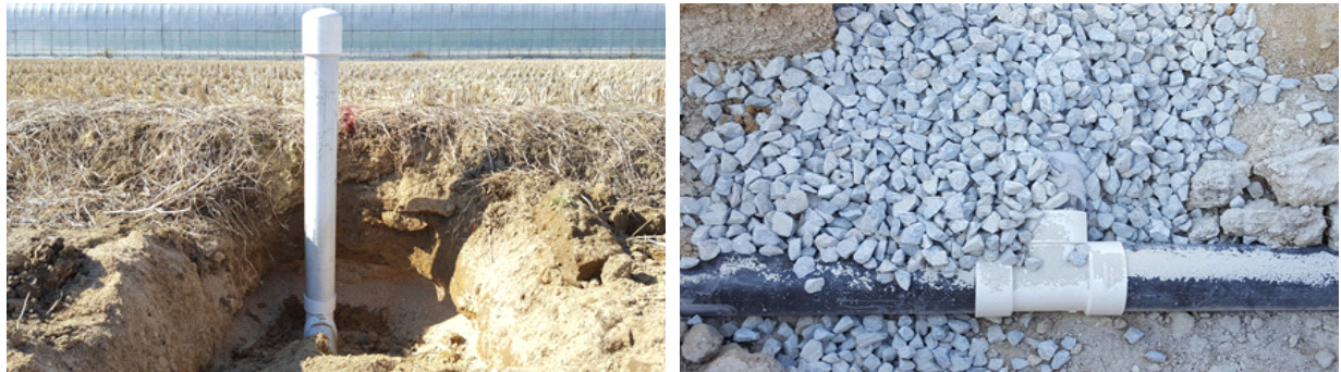
그림 2.2.28 암거 상단부 공기변 및 하단부 집수거 연결
