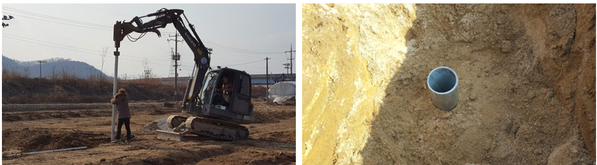
그림 2.2.33 지하수위 관측공 설치
