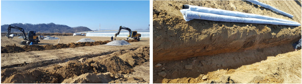
그림 2.2.25 자재 거치 주암거 터파기
