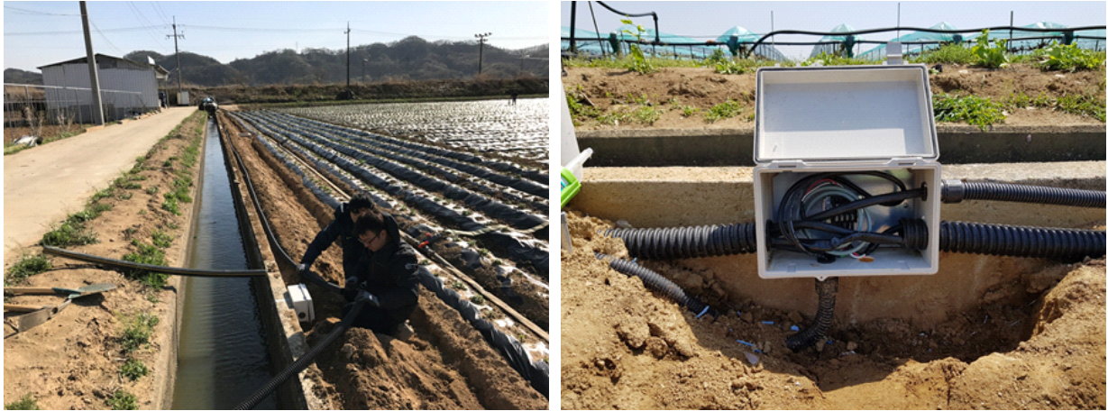
그림 2.2.39 제어반 연결용 케이블 매설 및 연결
