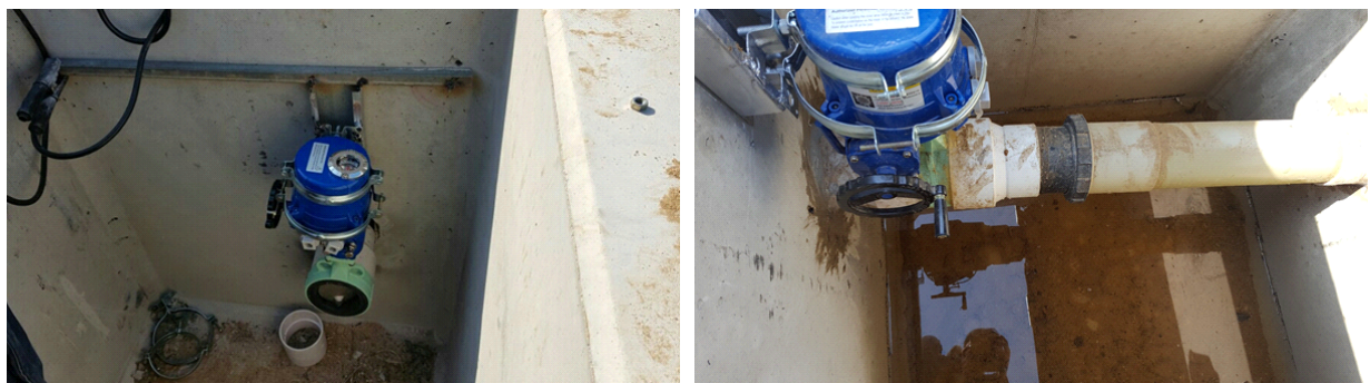
그림 2.2.30 지하수위 조절밸브 설치 및 암거 연결
