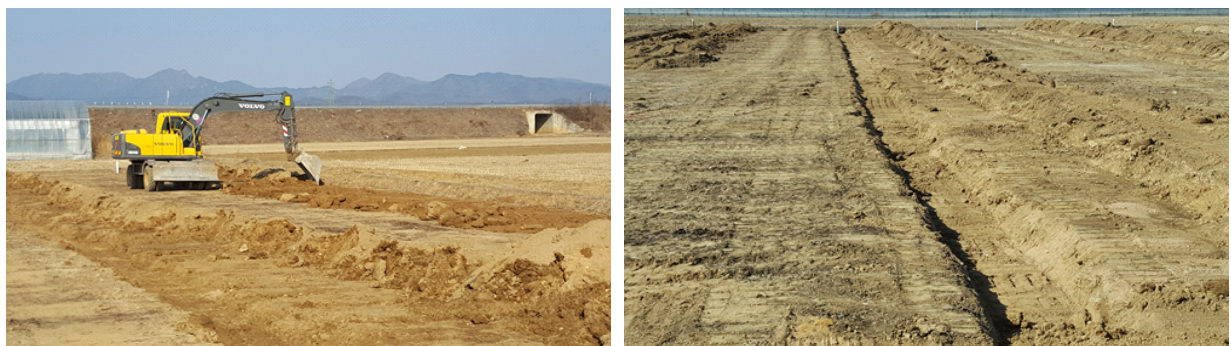
그림 2.2.29 주암거 설치 후 되메우기
