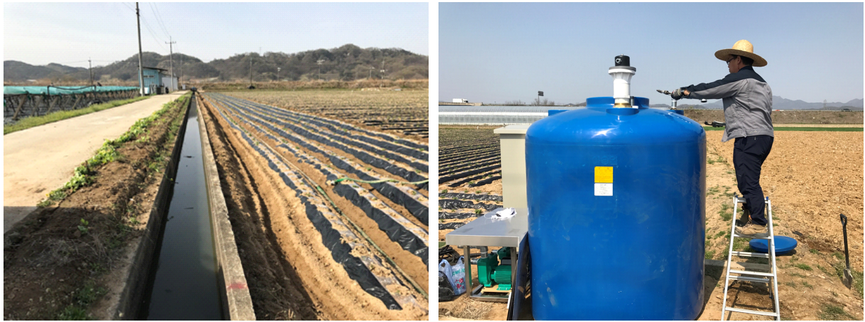
그림 2.2.18 프링클러 관개용 용수로(구역2 및 구역3) 및 저장탱크(구역1)
