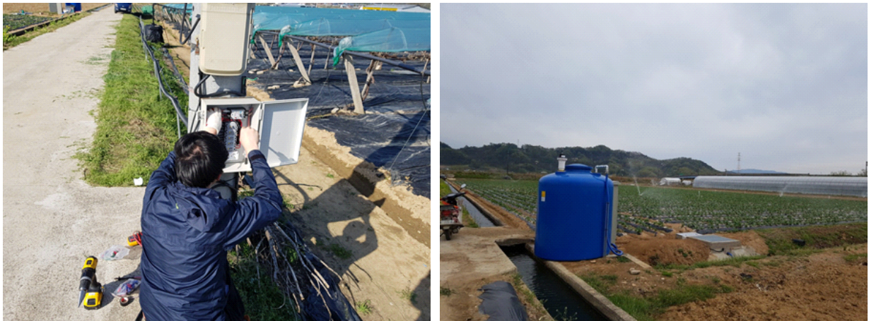
그림 2.2.21 시스템 전기 설치 및 작동확인
