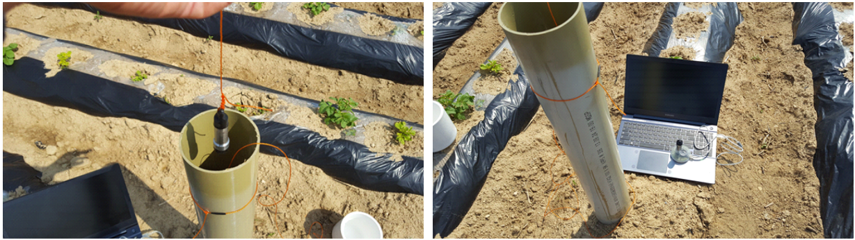
그림 2.2.34 지하수위계 설치 및 확인
