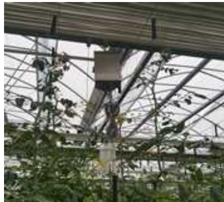
,건습구형 온도센서 설치>
