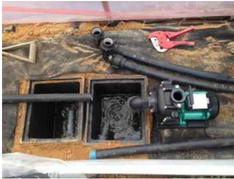
<펌프 설치 및 배관연결>
