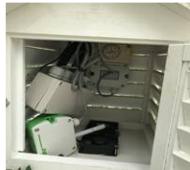
<백엽상내에 팬 설치>
