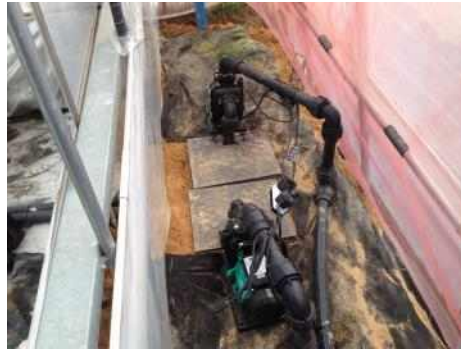
<펌프 설치 완료>
