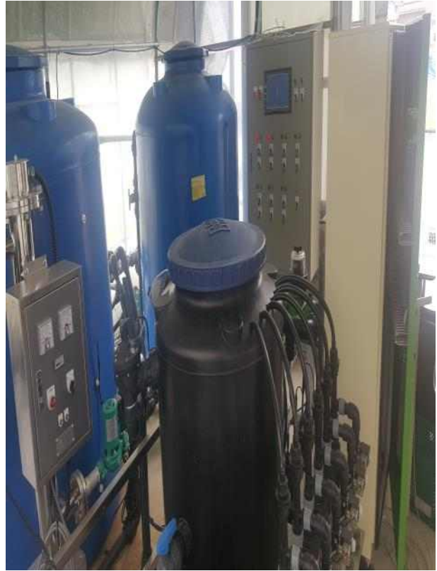
<배합통에 각 센서를 설치하여 EC 및 각 성분조성>
