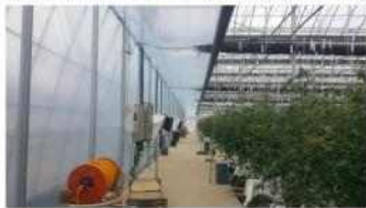
통로 측면 및 천장을 필름으로 막은 전경
