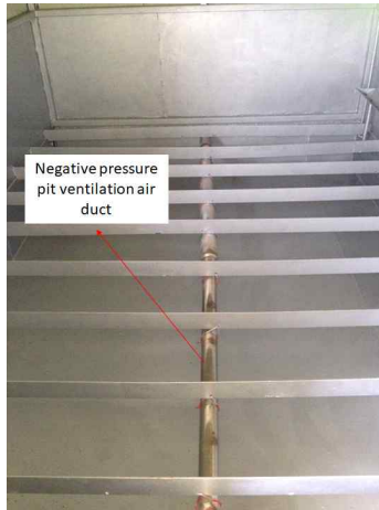
[그림 2.10] 피트 환기 음압 시스템실상도
