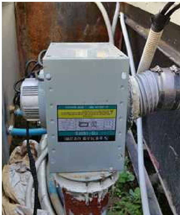
[그림 2.42] B형 돈사 피트 환기 시스템의 팬
