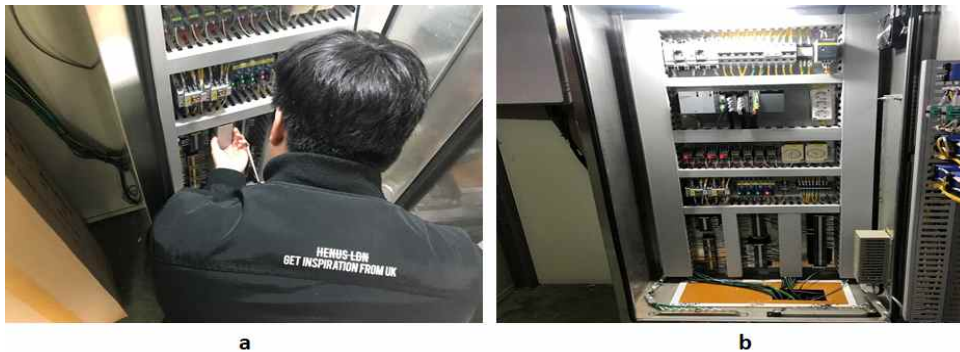
[그림 3.41] 모형돈사 A의 펌프 센서장치 (a) 연결하는 중 (b) 연결 후
