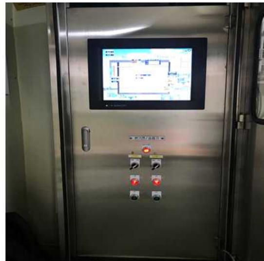
[그림 3.34] (a) 모형돈사 A, (b) 모형돈사 B의 설치료된 PLC패널
