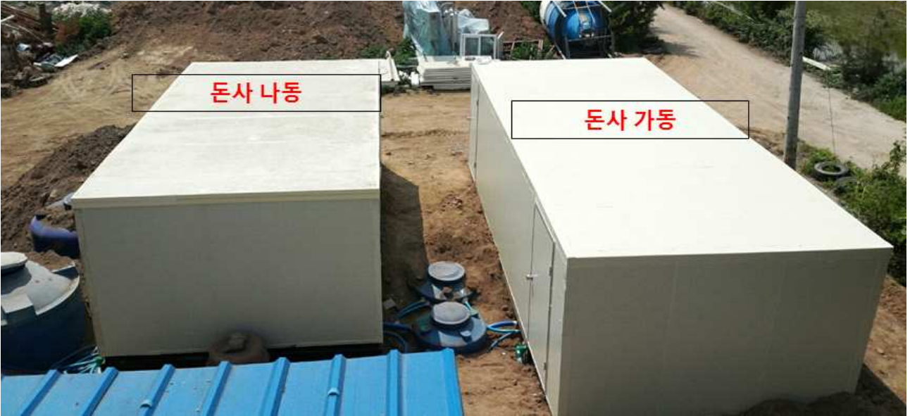
[그림 2.5] 현장에 설치된 실험돈사 실상도(돈사 가동㉠ 및 돈사 나동㉡)
