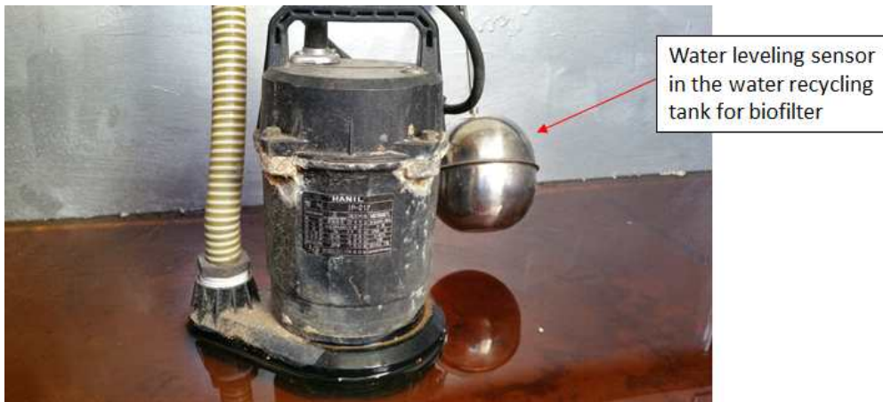
[그림 3.29] BF 재순환수에 인입되는 처리수 water leveling
