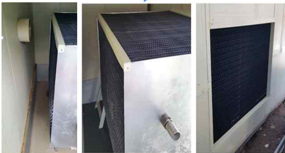
[그림3.6] 모형돈사A형 바이오필터시스템 실상도
