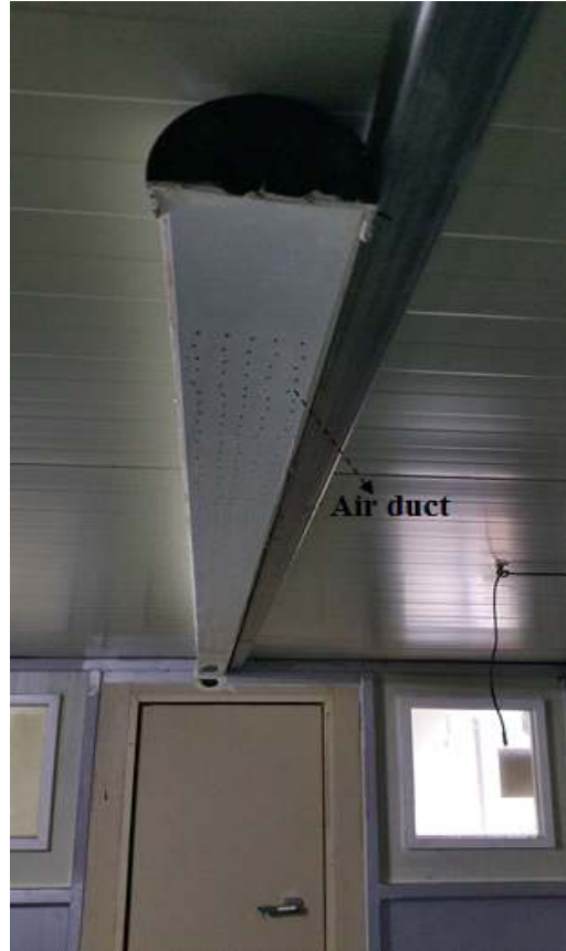
[그림 2.9a] 실험돈사 나동 (㉞수평형 바이오필터) 실상도
