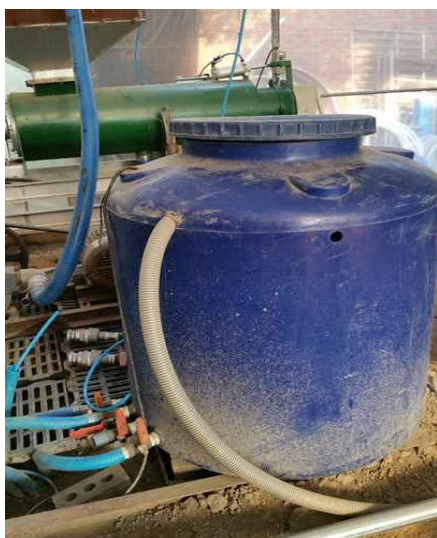
[그림 3.31] 바이오필터시스템 재순환 처리수조
