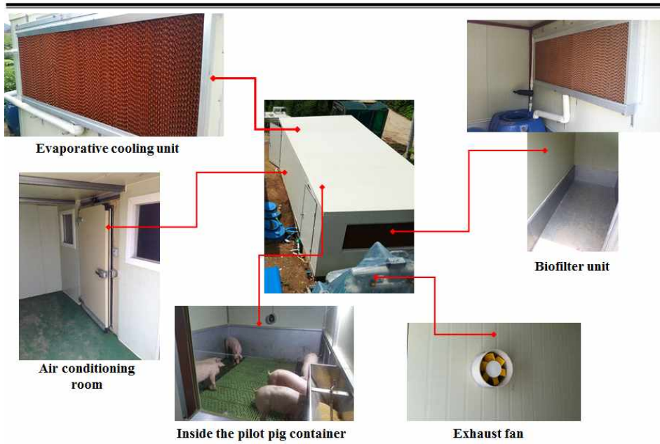
[그림 2.76] A형 환기 시스템의 상세 사진
