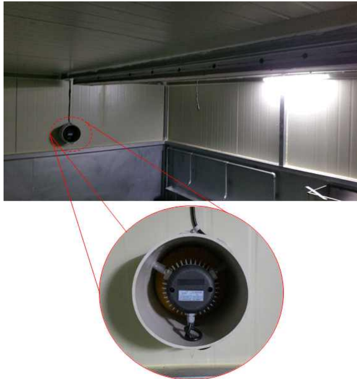
[그림 2.41] A형 돈사 벽체 환기 시스템의 팬
