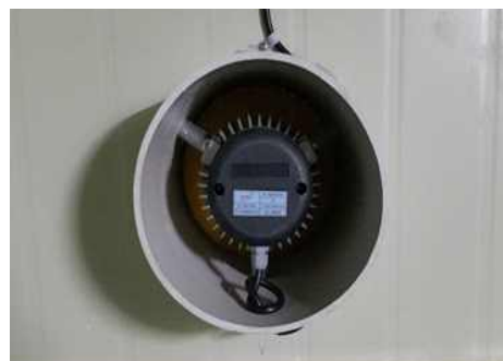
[그림 2.8d] 돈사 벽체에 설치된 팬
