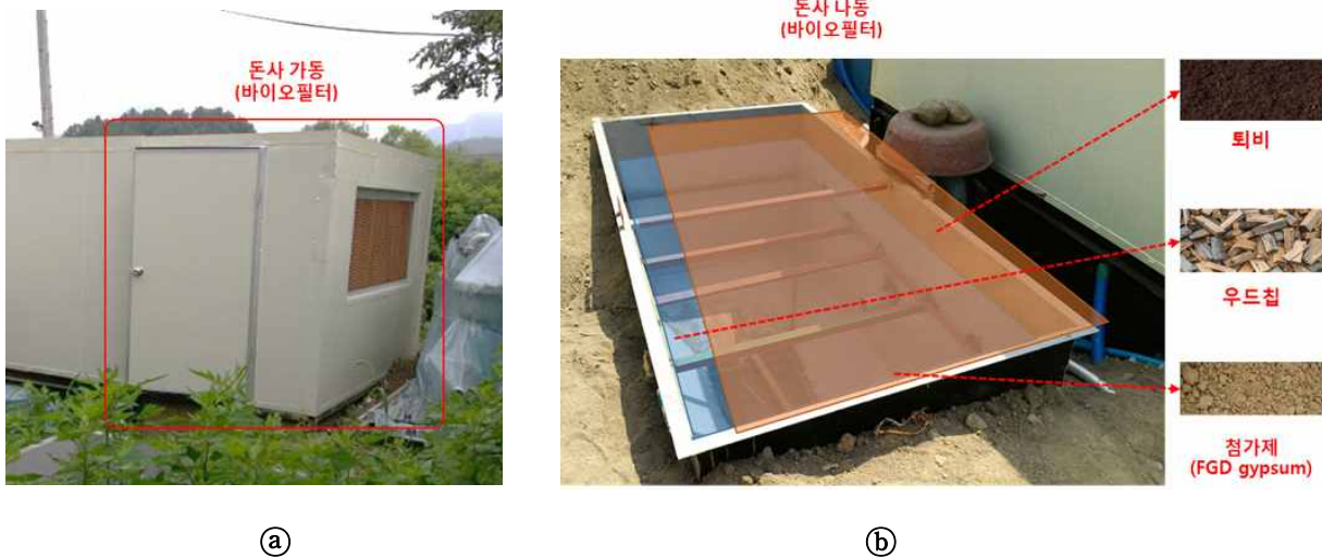
[그림 2.4] 실험돈사 바이오필터 설치모습 (㉓수직형 BF, ㉔수평형 BF)
