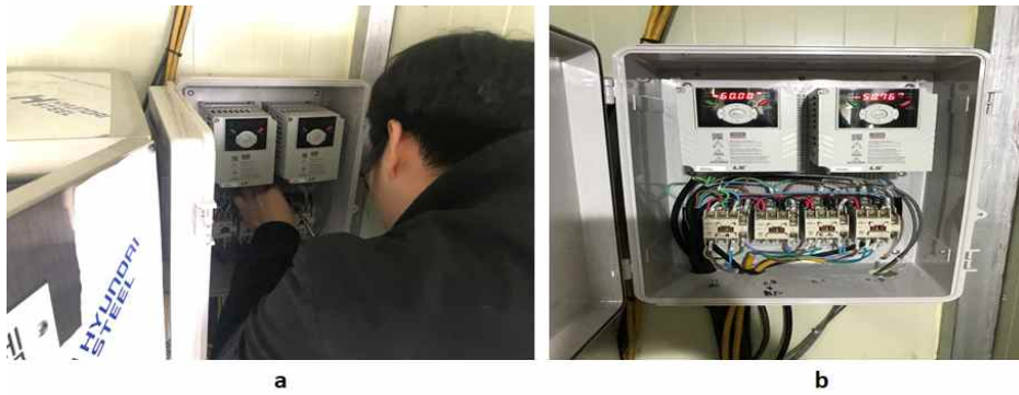
[그림 3.40] 모형돈사 B, C 패널 B 인버터 (a) 설치중과 (b) 설치후
