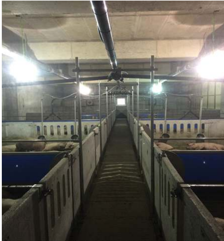
액상사료급이라인을 갖춘 돈방 중앙 복도의 슬릿을 통해 환기를 하는 '채널환기시스템' 구축
