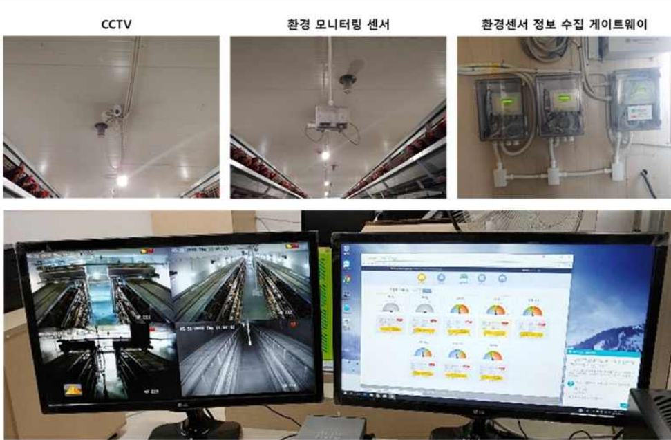
CCTV 및 계사 환경 정보 (온도, 습도, 이산화탄소, 암모니아) 디스플레이
