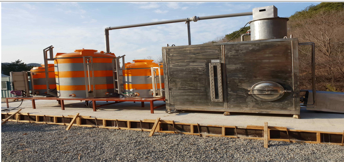
(고온호기액상발효 시설 설치)
