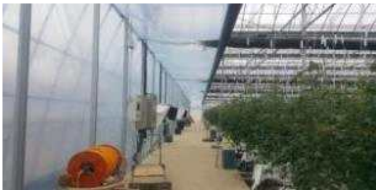
<통로 측면 및 천장을 필름으로 막은 전경>
