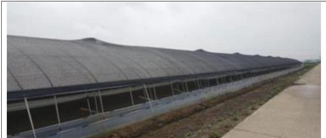
차광망 설치 전경
