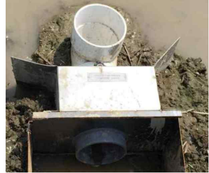
[수동식 배수물꼬 설치 사례]
