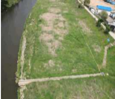
[자연형 배수로 설치]
