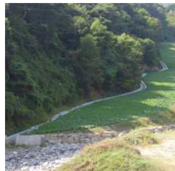
[밭둘레 물길 설치]
