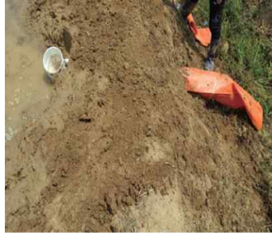
[논두렁 배수물꼬 설치]
