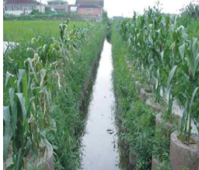
[자연형 배수로 설치]
