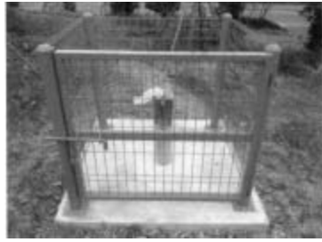
1) 관측공 굴착, 보호시설 설치
