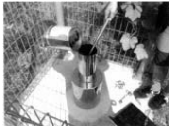
3) 관정내장형 관측장치 설치
