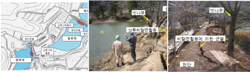
(a) 도마애저수지(堂前池) 평면도 (b) 중류지 상류사면 활동 (c) 상류지 상류사면 활동 출처 : 東日本大震災合同調査報告 地盤編1
