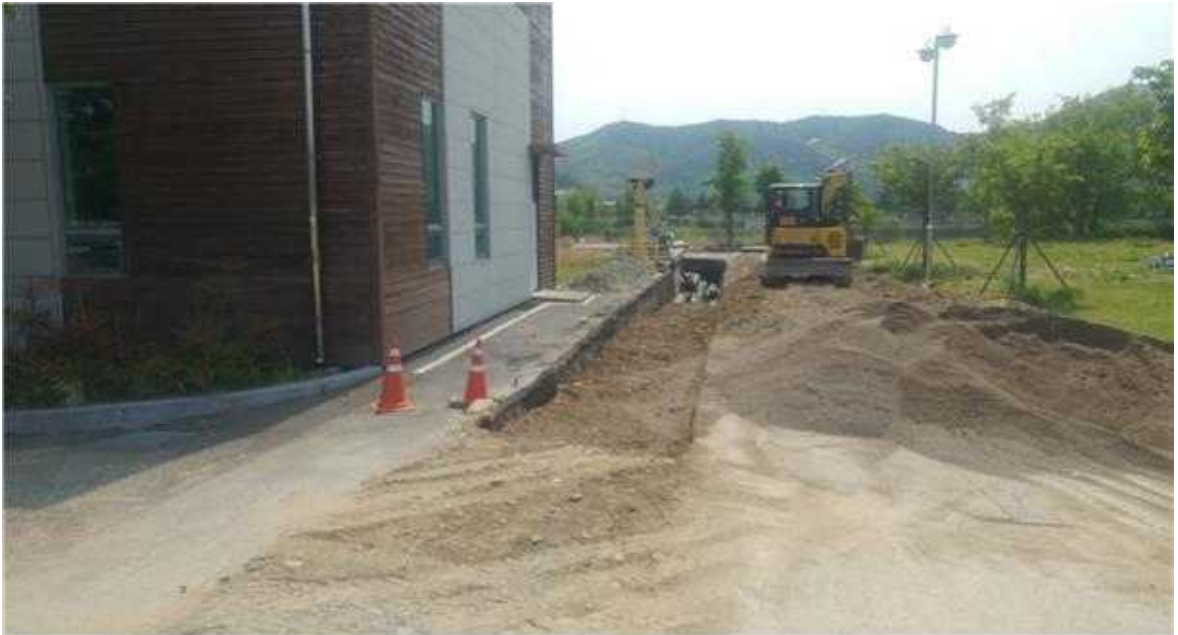
보문지구 형산강 지역 집수시설 공사 현장 점검 (경주시 보문동)
